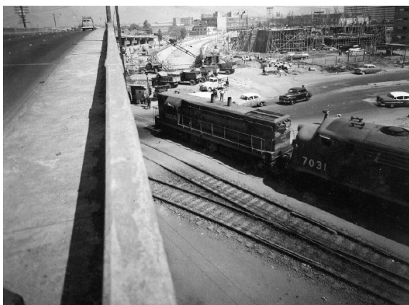
Ilustración 55. Construcción desnivel en Nonoalco. Fuente: FICA, 1960-1964.
