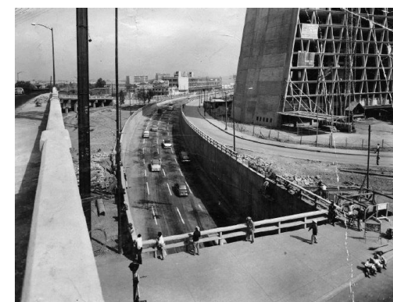
Ilustración 57. Construcción desnivel en Nonoalco III. Fuente: FICA, 1960-1964.
