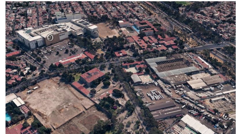
Ilustración 93. Equipamientos de la Magdalena de las Salinas. Fuente: Google Earth. 2020.
