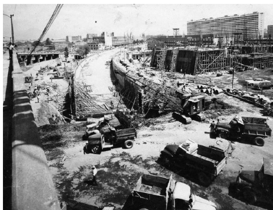
Ilustración 56. Construcción desnivel en Nonoalco II. Fuente: FICA, 1960-1964.
