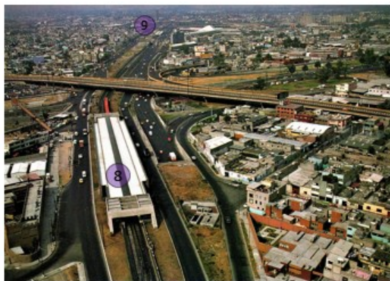
Ilustración 82. Estación La Raza Línea 5. Fuente: FB. Historias de la Ciudad de México en el Tiempo, 80's.
