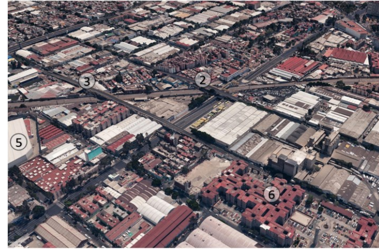
Ilustración 96. Puentes en colonia Atlampa. Fuente: Google Earth, 2021.
