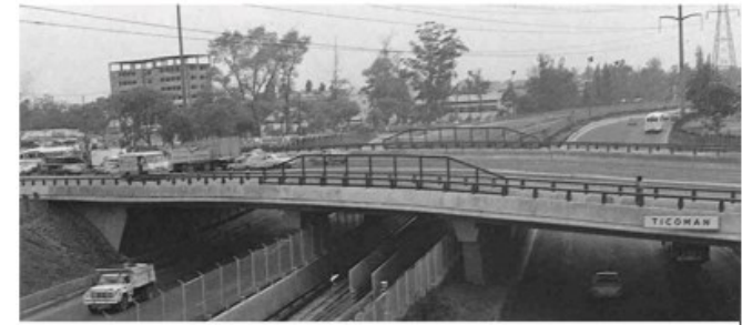
Ilustración 85. Av. Insurgentes Norte y paso de la Av. Ticomán. Fuente: FB. Historias de la Ciudad de México en el Tiempo, 1981.
