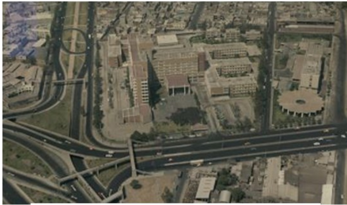
7. Hospital La Raza. Fuente: ICA, s/a.
