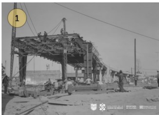
Ilustración 27. Puente Nonoalco. Fuente: MAF, 1940.
