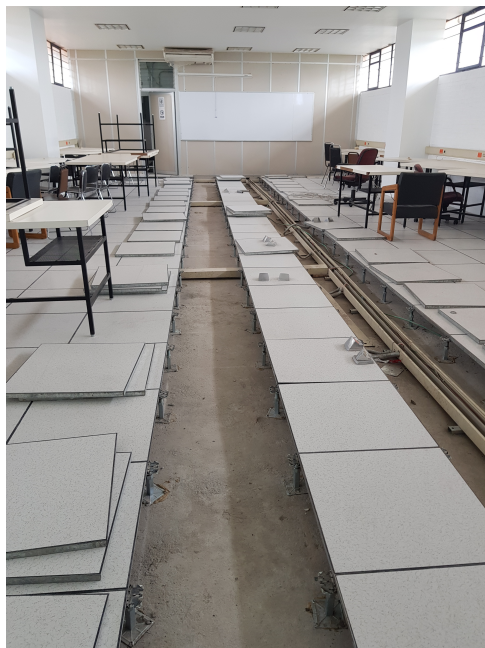
Figura 3.1: Colocación de piso falso
