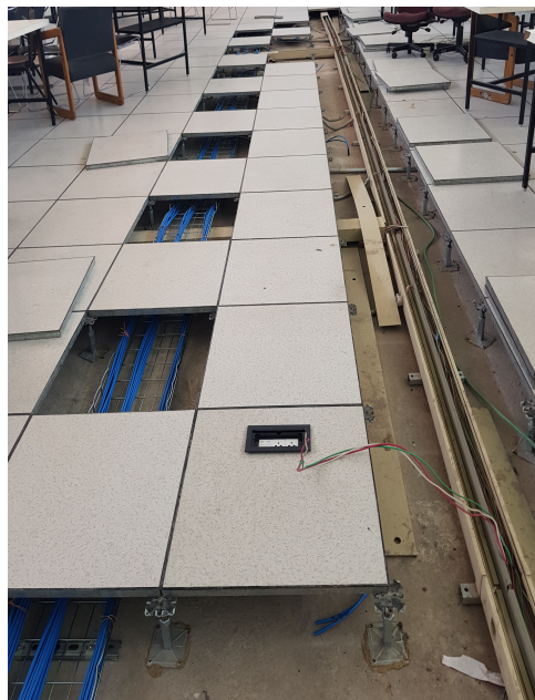
Figura 3.3: Tendido de cableado de red y electricidad
