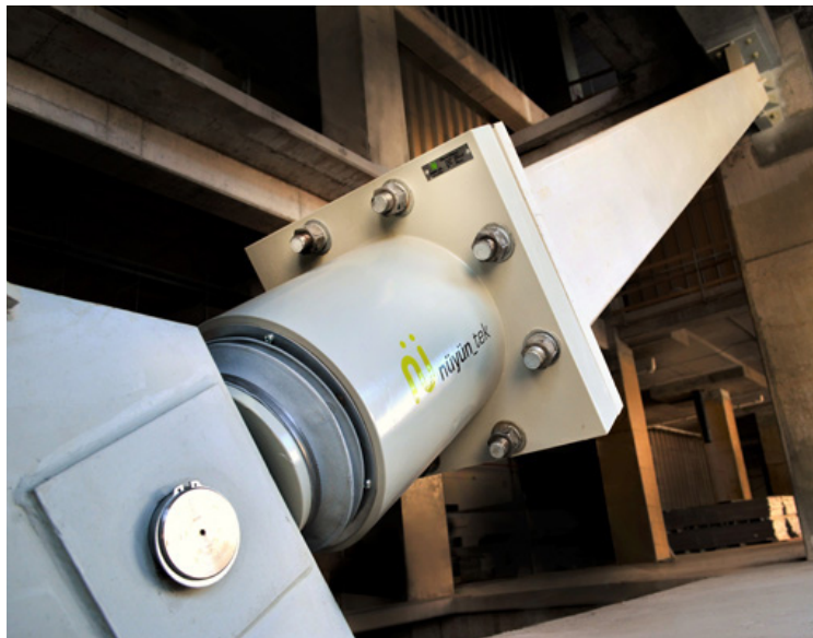
Figura 4.8 Disipador viscoso.
