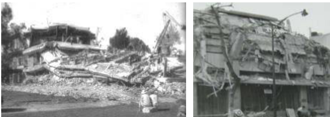
Figura 1.18 Edificios dañados en la Ciudad de México tras el sismo de 1957. Recuperado 2018 de Ventura, 2017, p. 2.
