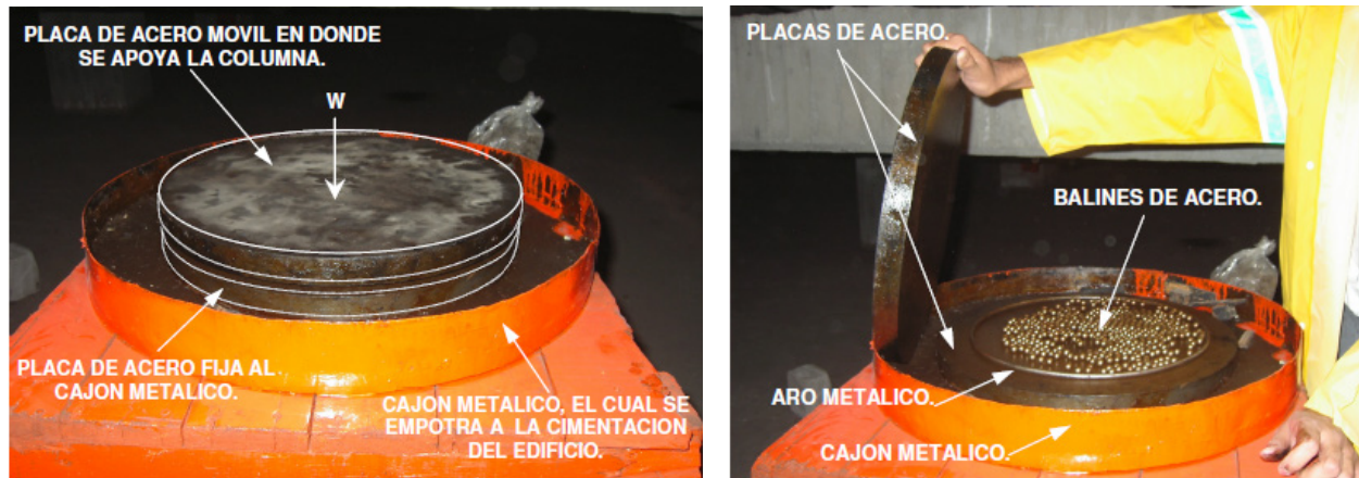
Figura 4.13 Tipo de aislador de superficie curva con el que cuenta la Escuela Secundaria Diurna N. 168. Fuente: Máximo, op.cit., p. 92
