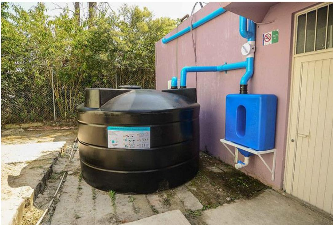
Figura 31. Sistema de captación de agua. Universo , (2021)
