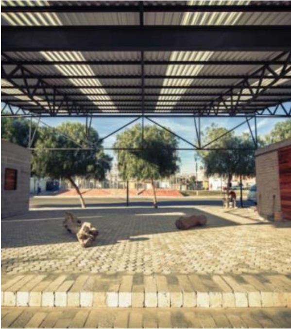
Imagen 28. Vista espacio de usos múltiples - Centro Comunitario Esperanza San Pablo. Autor: Yoshihiro Koitari. 2013.
