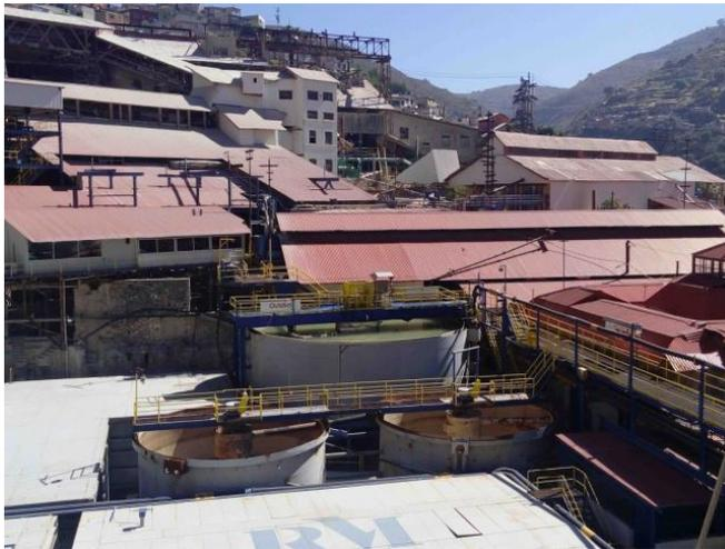
A diferencia de la fotografía anterior, en estas dos se puede observar que la planta renovada aprovecha los desniveles del terreno para ahorrar energía para el bombeo del flujo de la pulpa en proceso.
