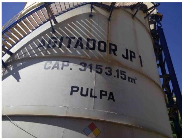
Los tanques de agitación fueron fabricados conforme a la capacidad diseñada de la planta y se tienen varios tanques por las mismas razones que se tienen varios molinos.
