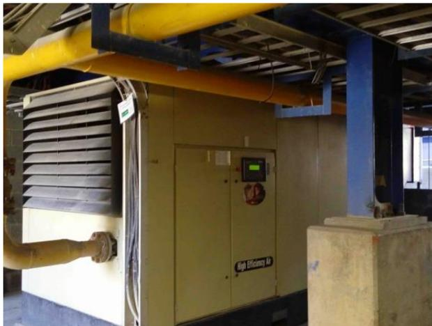
Detalle de la bomba de vacío para los filtros prensa
