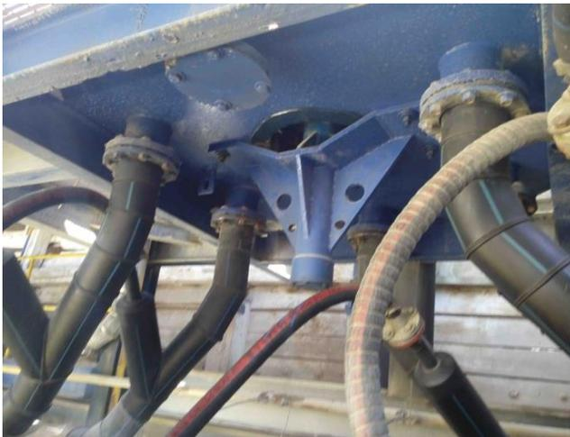
La pulpa se bombea a los tanques de agitación a través de ductos.
