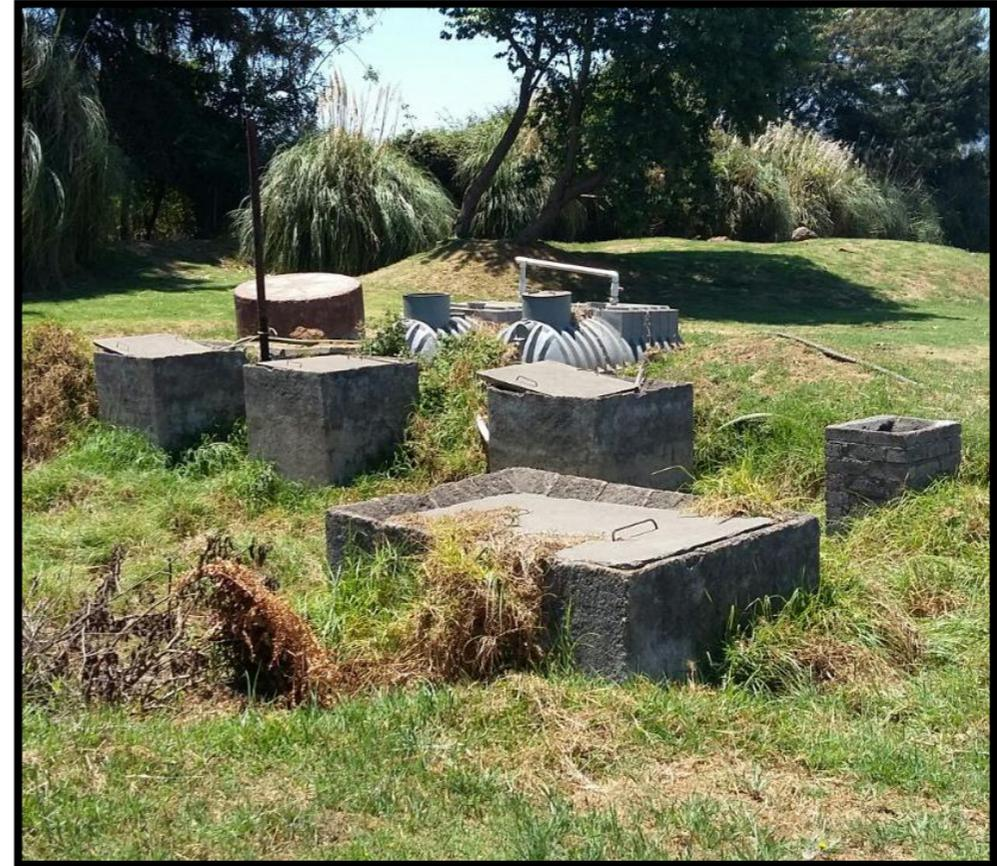
Para el tratamiento de aguas negras se utiliza un sistema de fosa séptica se muestra en la imagen, el cual está ubicado en una zona aislada del centro a unos metros de donde está ubicado el pozo de agua potable
