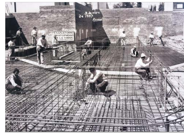
Trabajadores de la construcción durante armando la cimentación de lo que fue el Sanatorio Maternidad de la Torre, hoy ya no existente .
