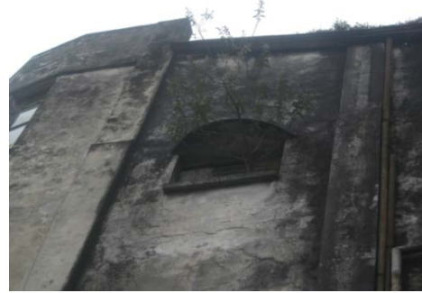
D-12 PRESENTA MICRO FLORA Y FLORA PARACITA EN LA MAYOR PARTE DE SUS PARAMENTOS.
