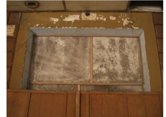
D-19 VANOS CEGADOS ALGUNOS CON MADERA Y OTROS MAS CON METAL .
