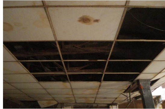
D-05 PRESENTA MANCHAS EN LOS PARAMENTOS POR FILTRACIONES DE AGUA Y POLVO.
