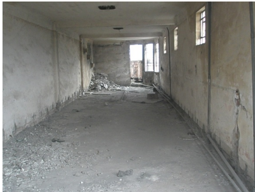
D-23 DESPRENDIMIENTO DE PINTURA EN PLAFONES ASICOMO HUMEDAD POR FILTRACION.
