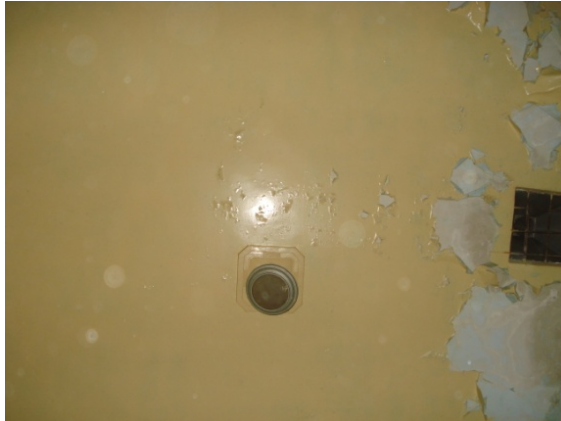
D-23 DESPRENDIMIENTO DE PINTURA EN PLAFONES ASICOMO HUMEDAD POR FILTRACION.
