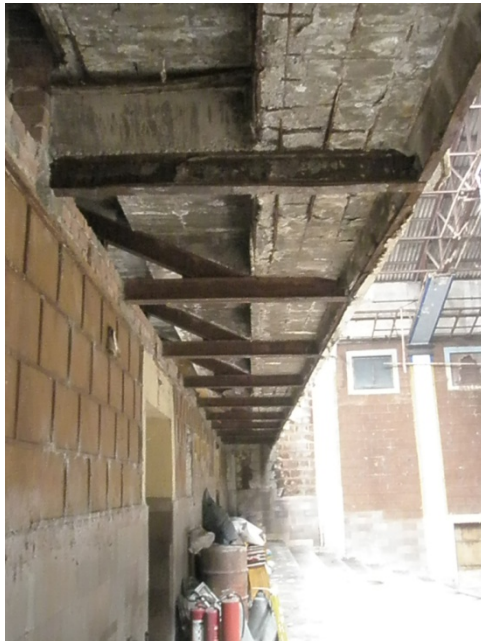
D-15 PRESENCIA DE ERRUMBRE EN LAS ESTRUCTURAS METÁLICAS DERIVADO DEL ESCURRIMIENTO DE AGUA PLUVIAL ANTE LA PERDIDA DE SU CUBIERTA.
