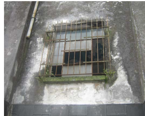
D-08 EXISTE OXIDACION EN HERRERIAS POR LA PERDIDA DE SUS RECUBRIMIENTOSQUE LE DABAN EL ACABADO FINAL.
