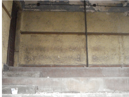
D-24 PRESENTA SALINIDAD Y EFLORESCENCIAS EN SUS PARAMENTOS INTERIORES POR ESCURRIMIENTO DE AGUA PLUVIAL.
