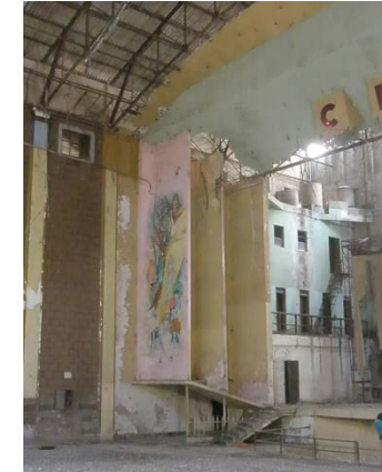
D-01 EN UNA DE SUS BAMBALINAS SE TIENE PERDIDA PARCIAL DE LA PINTURA MURAL
