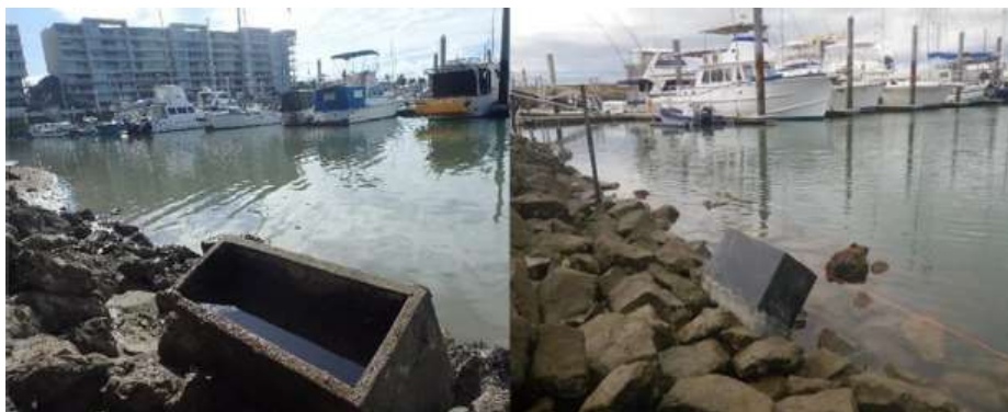
Figura 11. Estructuras huecas para fomento de microhábitats direccionadas 45^{\circ} desde la vertical hacia tierra adentro y hacia mar adentro respetivamente (Waltham et al., 2018).
