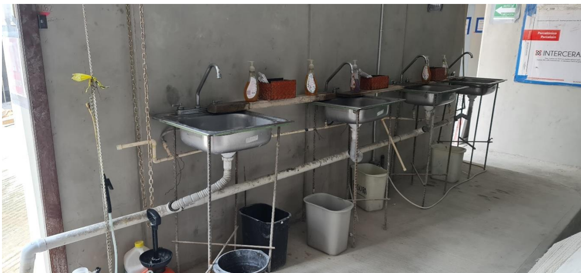
Ilustración 8. Adecuación de áreas para lavado de manos.
