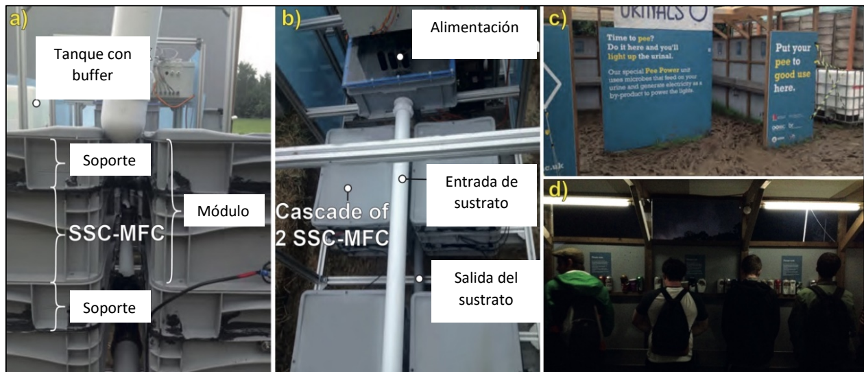
Figura 4.3. Instalación del sistema de sanitarios en el festival de Glastonbury, U.K. en 2016. A) Arquitectura de cada módulo con dos cascadas cada una. B) Disposición de ambos módulos y alimentación de sustrato de los mismos. C) Entrada a los sanitarios para informar a los usuarios. D) Uso de los sanitarios por parte de los usuarios (Ieropoulos y col., 2020).
