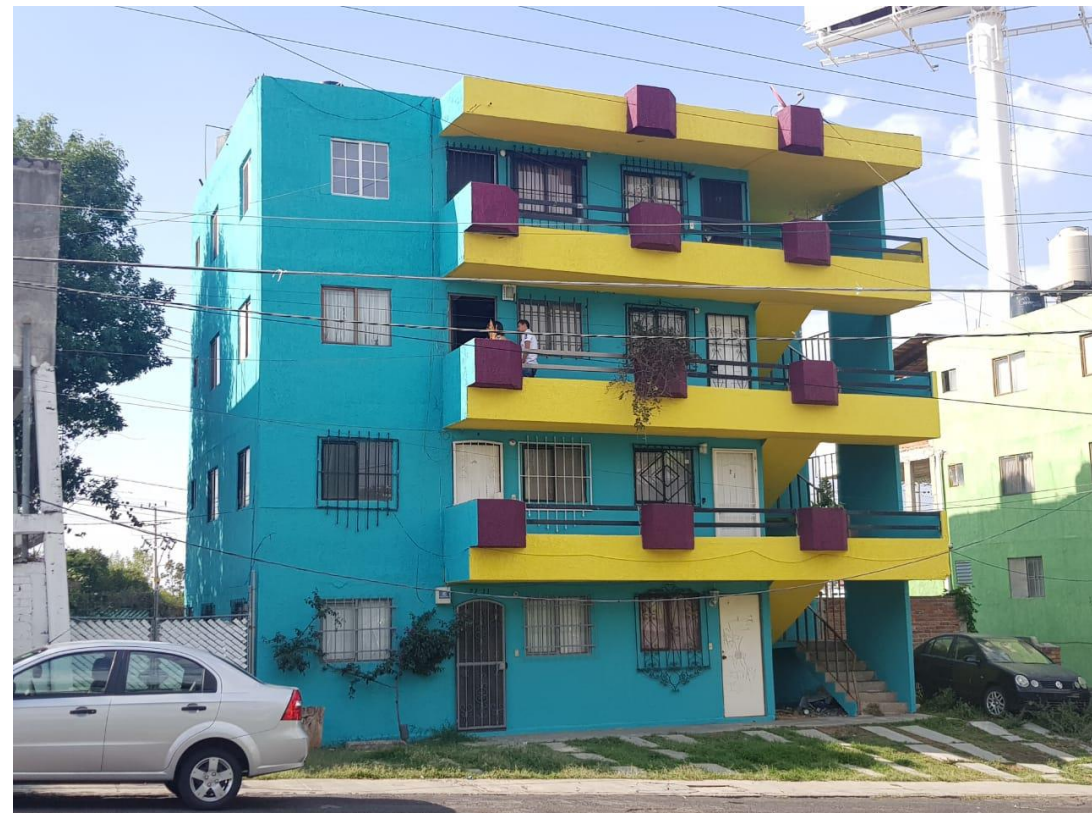
Fachada tipo de fraccionamientos seleccionados fachada 25m 2 por vivienda. Edificio multifamiliar de 8 departamentos.
