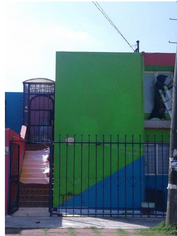
Protección de pisos, escaleras, barandas, etc... por medio de lonas o plásticos.
