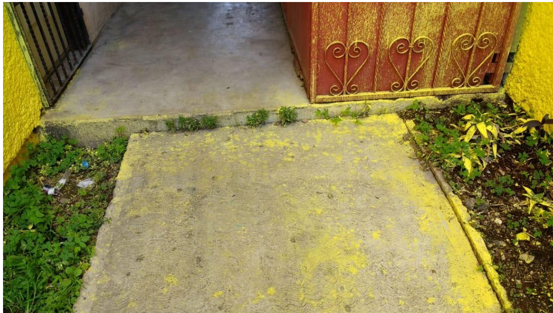
Evitar manchar herrerías, pisos y otros elementos en las fachadas.
