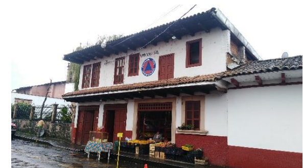
Mercado y protección civil. Después.
