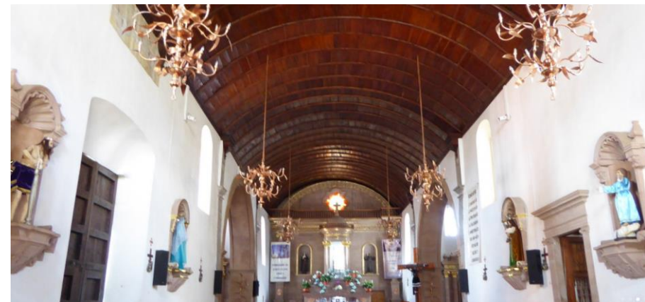
Interior iglesia, Nuestra Señora del Sagrario, bóveda de Cañón corrido de cobre.
