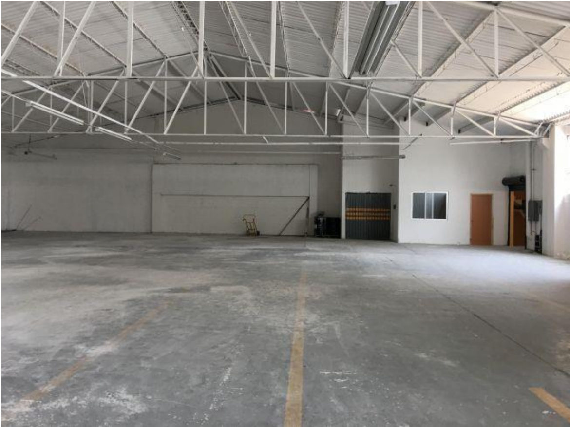
Figura 18. Vista interna de la bodega
