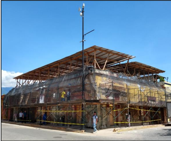
Imagen 5.3. Proceso de rehabilitación de inmueble patrimonial
