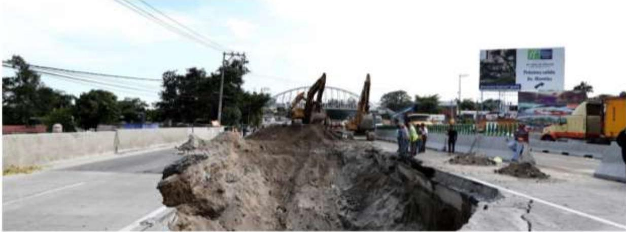
Figura 2.- Socavón de cuatro metros de diámetro y cinco de profundidad en el kilómetro 93+850 del Libramiento de Cuernavaca Morelos. (González, 2018)
