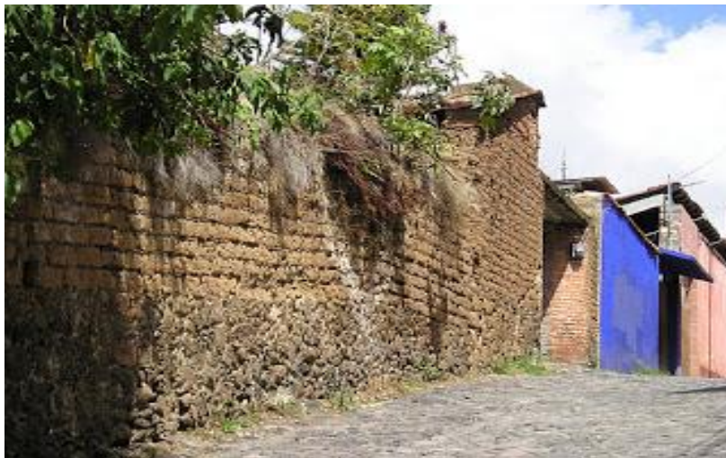
Gráfico 52. Ejemplo de materiales de la zona y su ejecución en obra (Adobe). Fuente: secretaria de turismo
