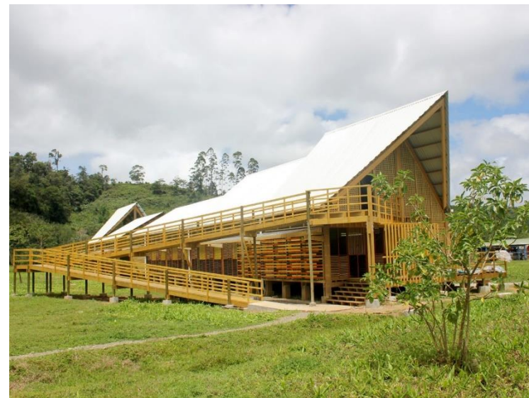
Vista exterior del Centro de Capacitación Indígena Kăpäclăjui en Costa Rica. Autora: Ingrid Johanning.
