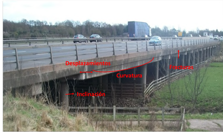
Fig. 1.10. Aplicaciones de medición en monitoreo estructural [37].
