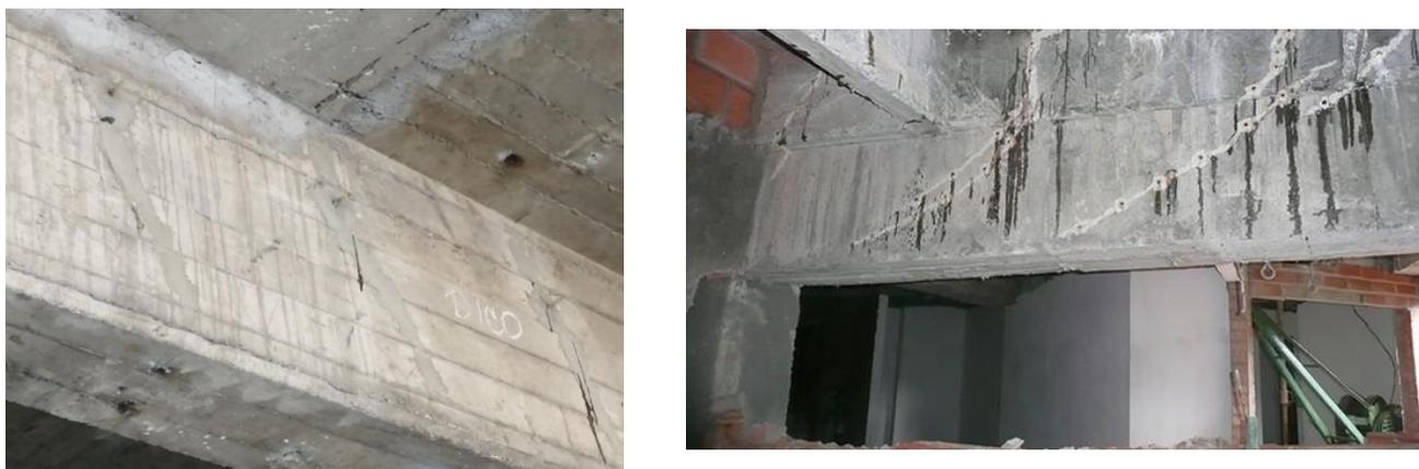
**Figura 60 Reparación de grietas en vigas (Abarca, 2020)**
