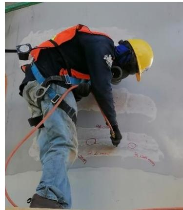
*Figura 18 Limpieza de las grietas con un compresor de aire (Abarca, 2021)*
