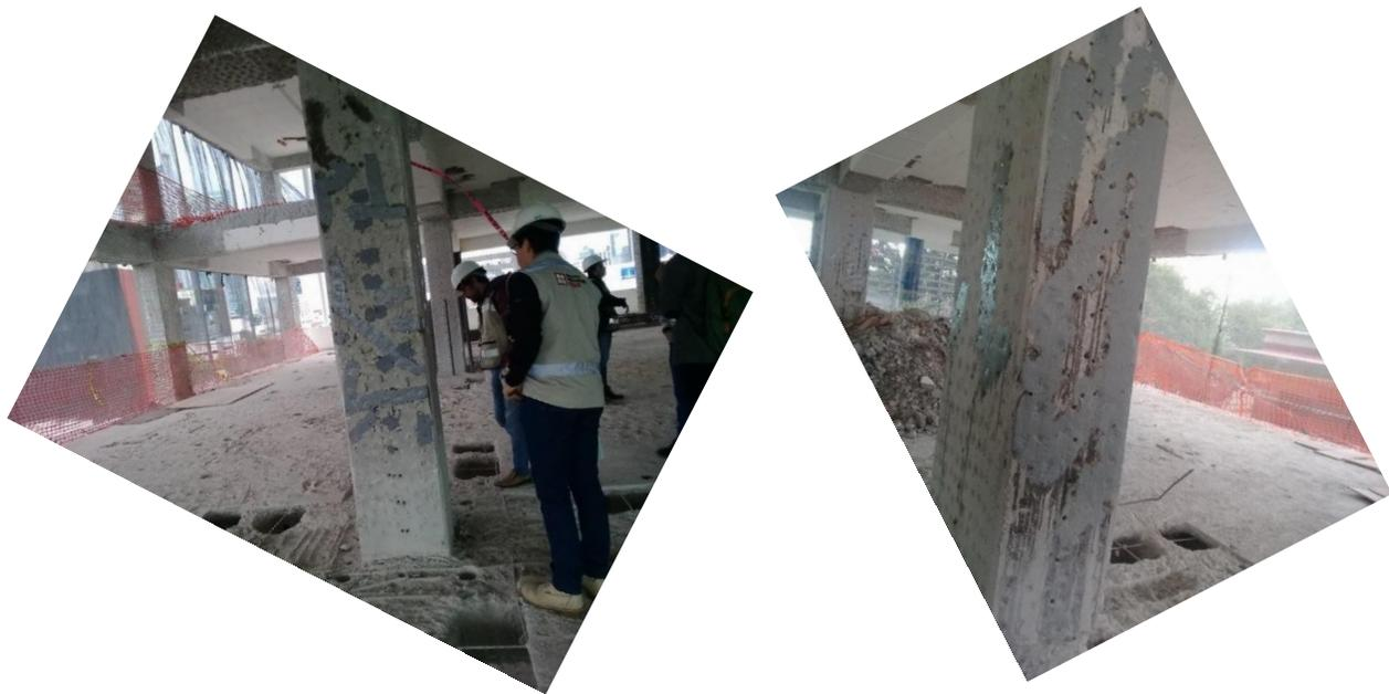
**Figura 59 Reparación de grietas en columnas (Abarca, 2020)**
