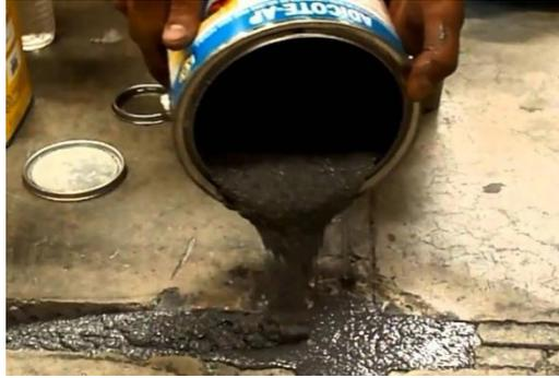
**Figura 69 Ilustración de un mortero de tipo epóxico**
