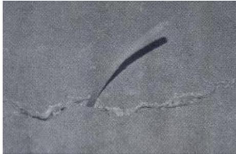
**Figura 26 Colocación de boquilla por el método de inserción (Trout, 2006)**
