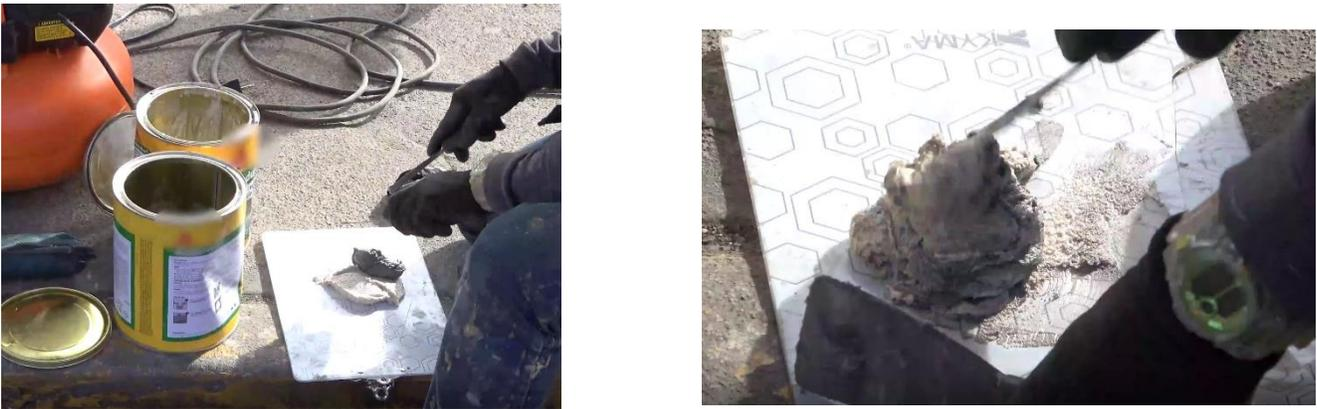
**Figura 19 Mortero epóxico como sellador de grietas (Abarca, 2021)**
