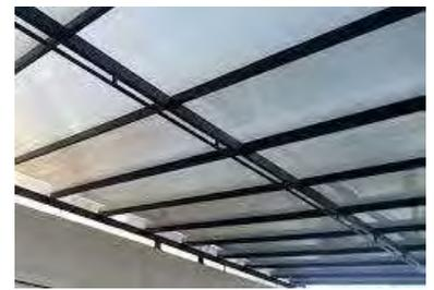
Imag. 88 Lamina de policarbonato semitransparente de 6mm. Google Imágenes (2021)
