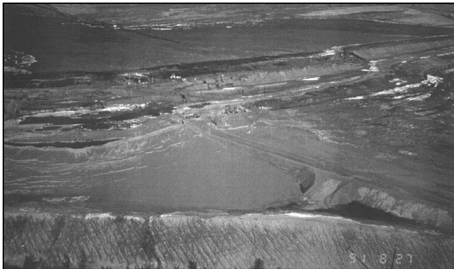
Figura 6.4. Vista aérea de la falla en la Mina de Sullivan (Davies, 1999).
