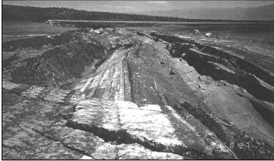
Figura 6.5. Vista local de la falla en la Mina de Sullivan (Davies, 1999).
