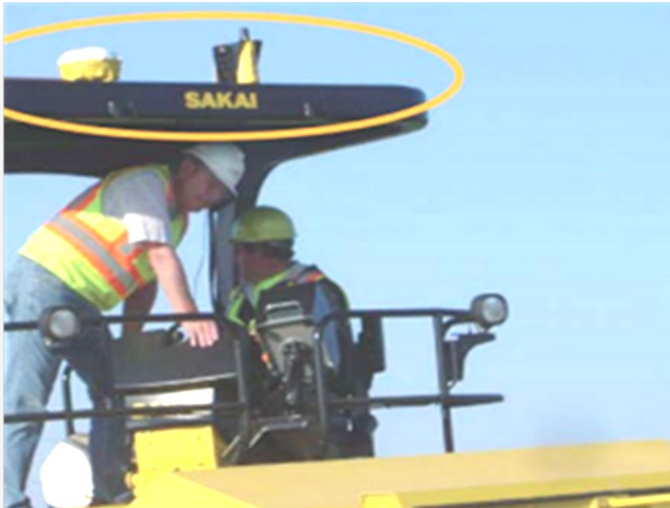
Fig.III.3.2 Receptor y antena GPS en un compactador SAKAI.
