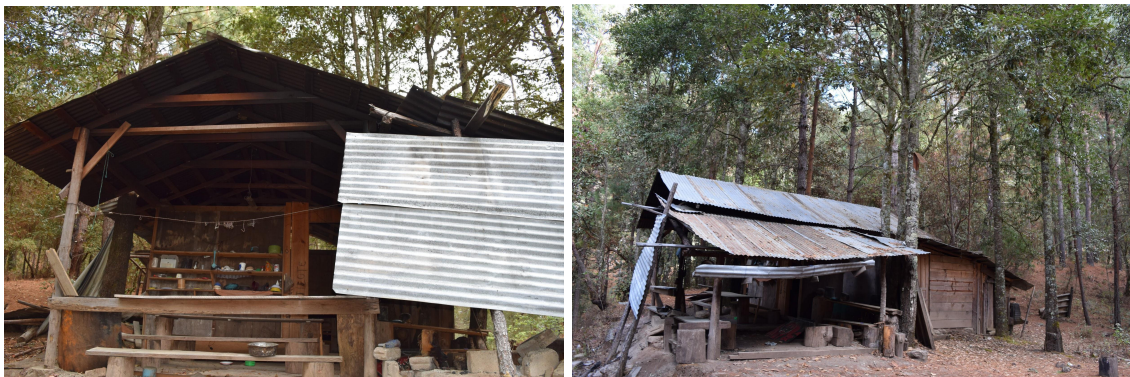
Figs. 20 y 21. Casetas de vigilancia que antes eran utilizadas para alimentar a quienes trabajaban en el aserradero.
