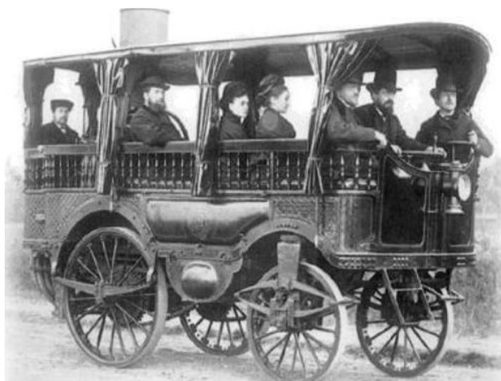
*Figura 4.2.- Autobús propulsado por un motor a vapor.*
