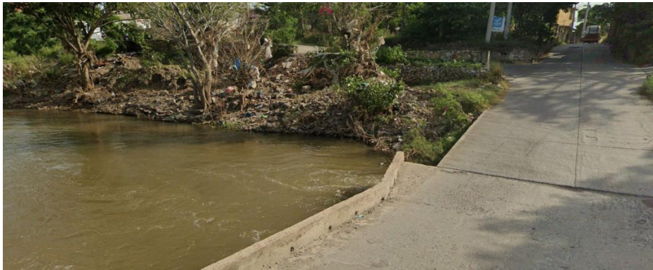
Figura 7.3. Sección del río Los Perros con obra de protección, Juchitán, Oaxaca.
