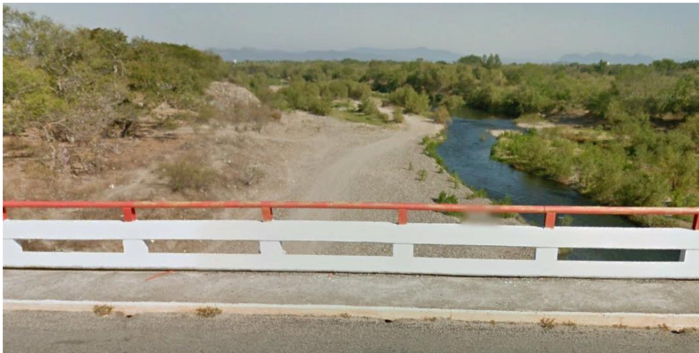
Figura 7.20. Cauce del río Los Perros en condición actual, ciudad Ixtaltepec.
