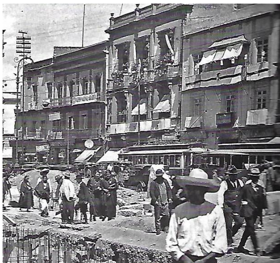
Imagen CVII. Excavación para la instalación de la fuente de fray Bartolomé de las Casas en la calle de Seminario, ca. 1923 (fragmento). Fuente: Sánchez Reyes, Gabriela (2019). Origen y desarrollo de la Plaza del Seminario. México: INAH, pág.146.
