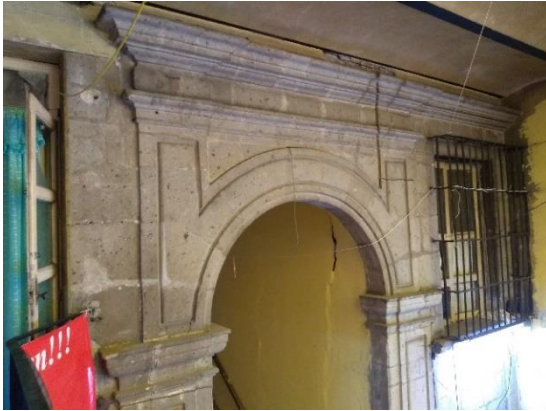
Imagen XLVI. Arco de cantera gris de los Remedios. Fuente: fotografía RGM
