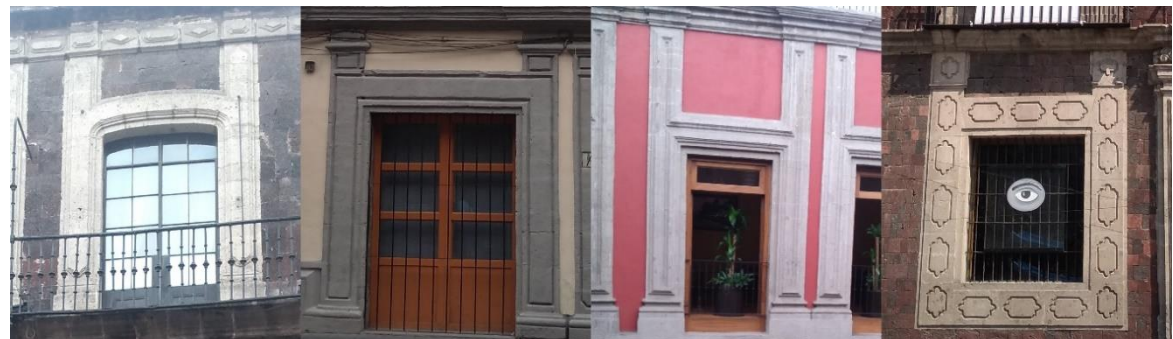
Imagen LXXIII. Enmarcamientos en forma de H, típicos en la arquitectura civil de la Ciudad de México. De izquierda a derecha: casa Borda, de Guatemala #91, de los condes de Xala y de Seminario #12
