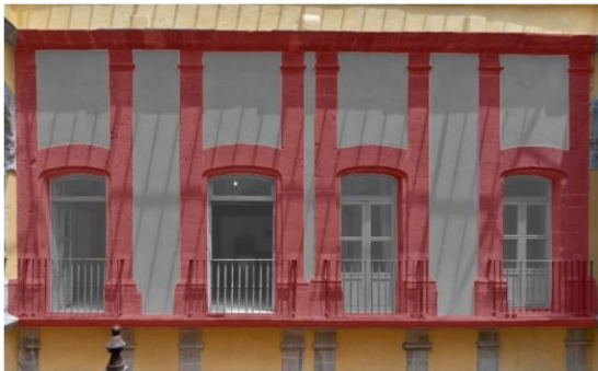
Imagen LXXV. Enmarcamientos en forma de H, ligados a cornisa superior e inferior; casa Borda. Fuente: dibujo propio sobre fotografía de airbnb, tomada de https://www.airbnb.mx/users/show/3285196?_set_bev_o_n_new_domain=1615230686_YmQxZGVINW11Nzdi
