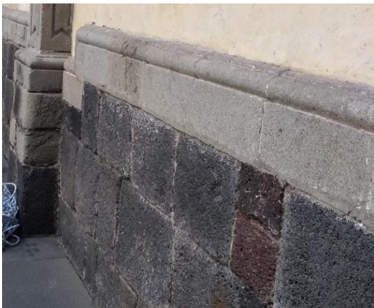
Imagen LXIII. Rodapié de tezontle y cantera gris de los remedios, Casa del Seminario #12. Fuente: fotografía RGM.
