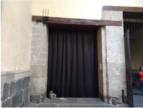
Imagen LXXVI. Dinteles de madera. Fuente: fotografía RGM.
