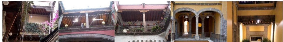
Imagen XCIII. Solución para techar el corredor de desembarque de la escalera. De izquierda a derecha: Seminario #12, condes de Xala, Tlaxcala, Borda y Sirenas. Fuente: elaboración propia a partir de fotos de distintos autores.
