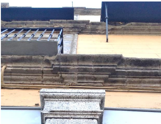
Imagen CIX. Resalto en cornisa. Fuente: fotografía RGM.
