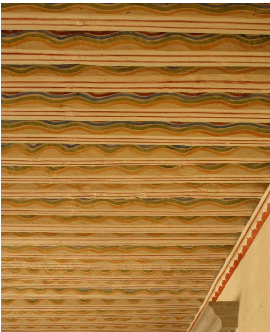
Imagen CI. Vigas de madera pintadas. Fuente: http://seminario12.squarespace.com/
