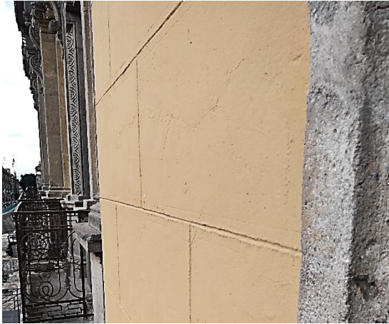
Imagen CVI. Detalle del aplanado de la fachada de la casa de Seminario #10. Fuente: fotografía RGM.
