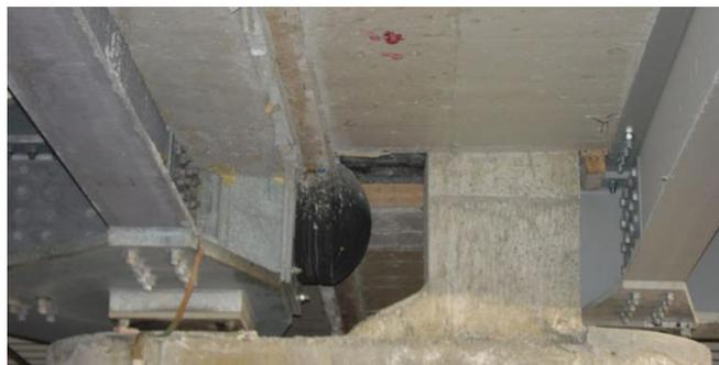
**Figura 1.16 Banda de goma instalada en la junta constructiva de un edificio en Nicosia, Chipre (Polycarpou & Komodromos, 2014).**
