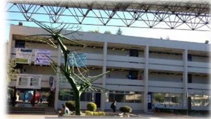
Ilustración 130. Edificio tipo de aulas. F.E.S Zaragoza.
