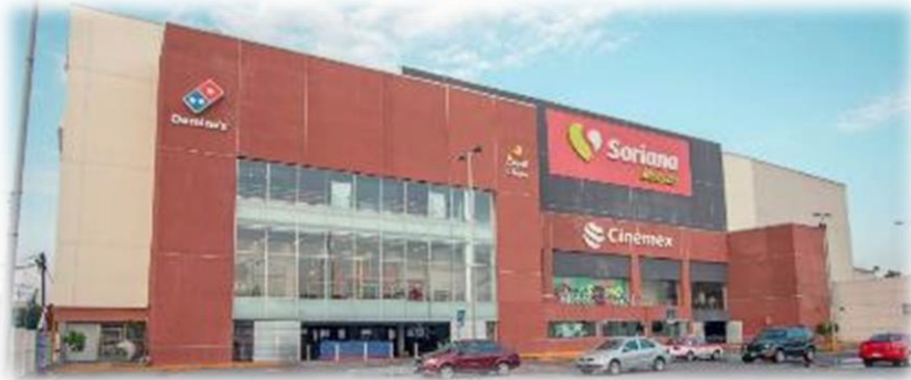
Ilustración 129. Plaza Vía San Juan. Imagen tomada de Google.
