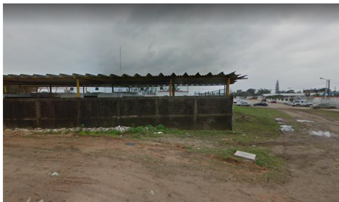
Figura 22 Lado sur del terreno.
