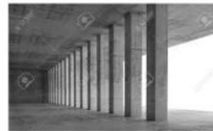
Siguiendo la retícula librando claros de 10m, las columnas serán de concreto armado Y los entrepisos de losa nervada unidireccional.
