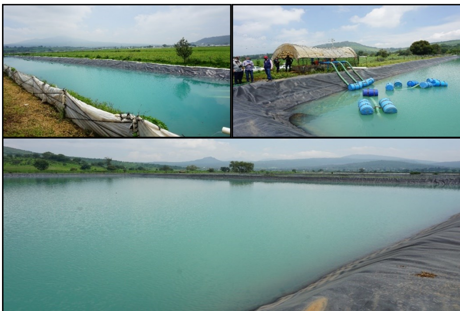
Figura IV-38. Ollas de acumulación de agua para riego en rancho de la empresa Biotegro en Lagunillas.
