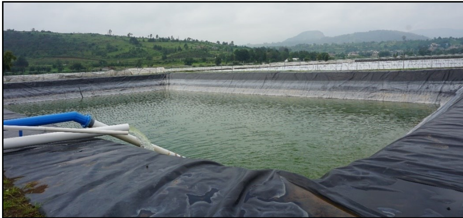
Figura IV-37. Fotografía de la olla de acumulación de agua para riego del rancho La Tuzarela en Lagunillas.
