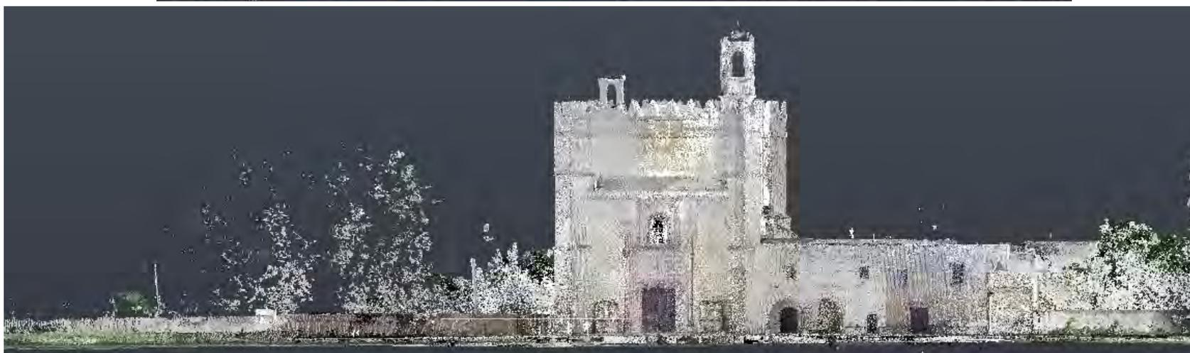
*Fig. 6. 31. Corte transversal y fachada Oeste del Convento de San Miguel Huejotzingo, por medio de nube de puntos.*
