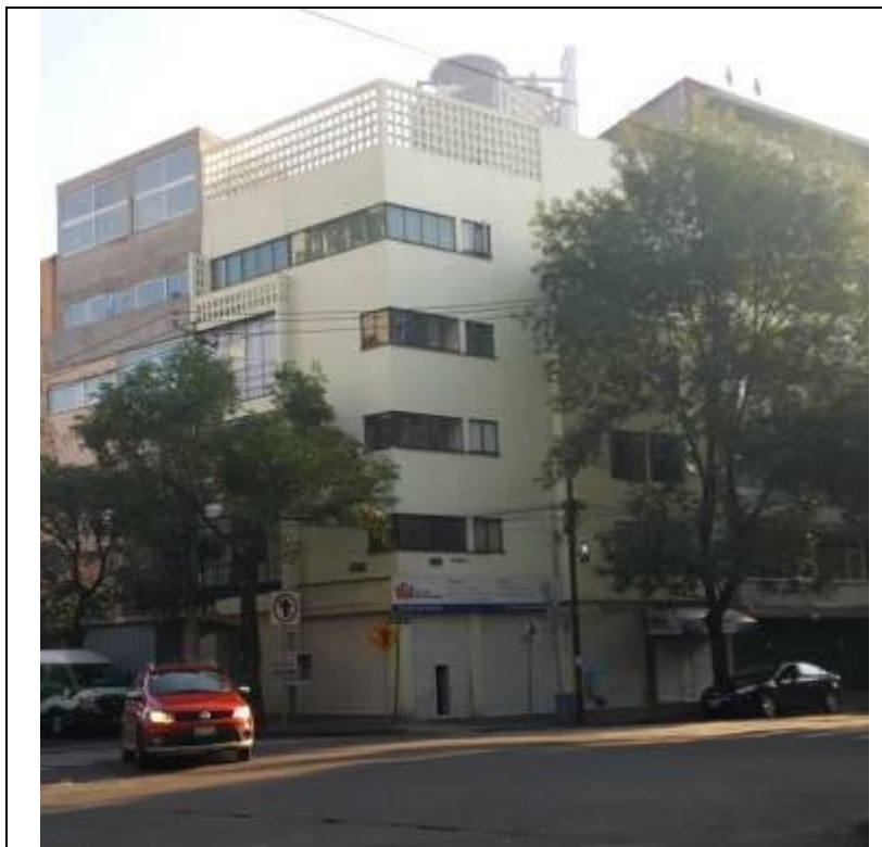
FACHADA DEL EDIFICIO AV. VERACRUZ
