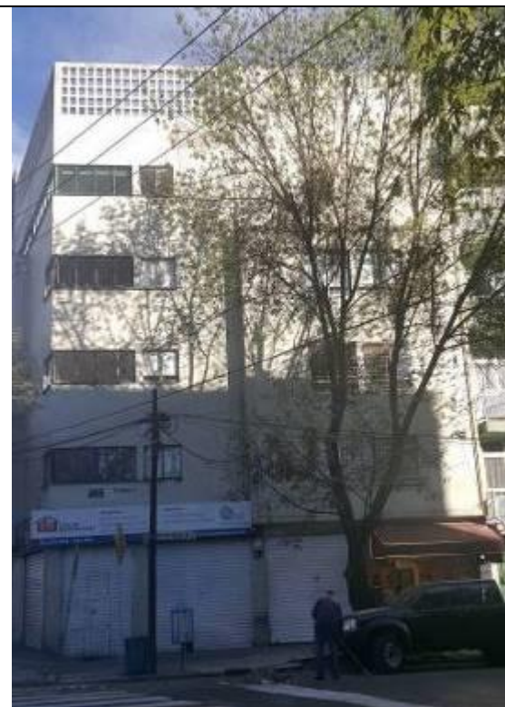
FACHADA POR CALLE PUEBLA
