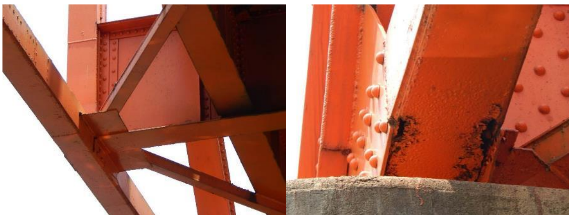
Figura 14. (a) Vista general de la cuerda inferior y (b) detalle de cuerda inferior en la conexión con el apoyo.
