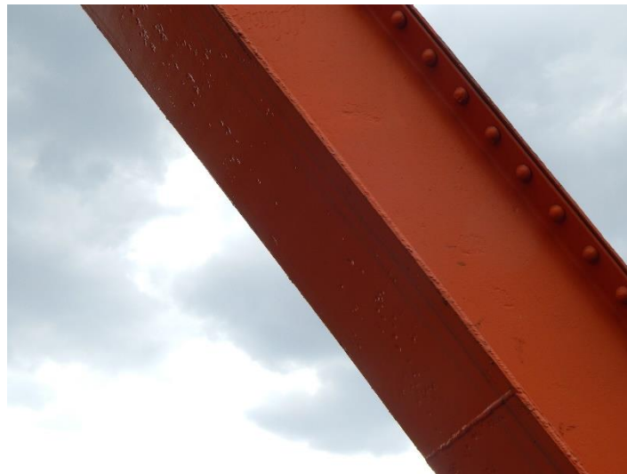
Figura 51. Reforzamiento de elementos de cuerda superior y montantes extremos
