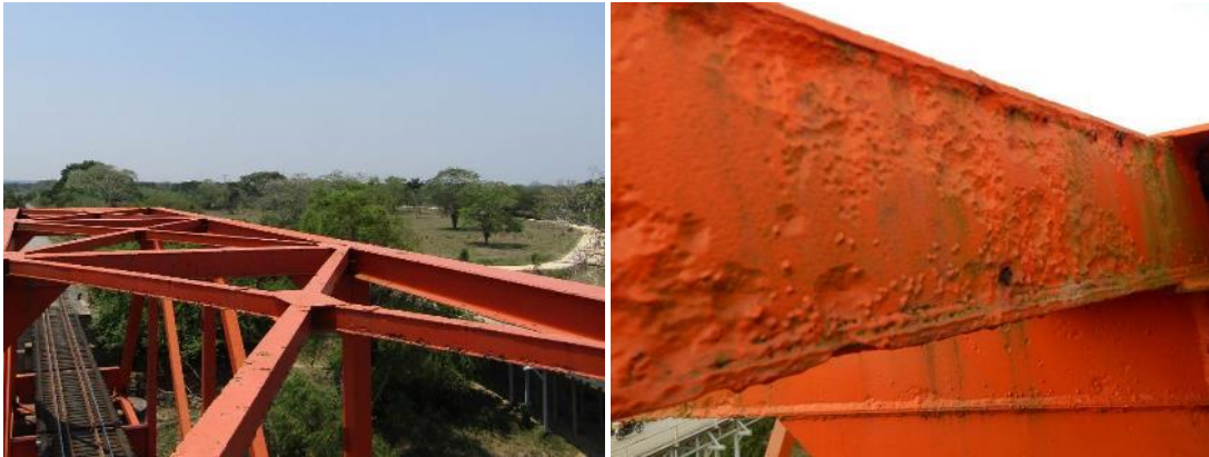
Figura 18. (a) vista general del contraventeo superior y (b) detalle de la sección del contraventeo superior
