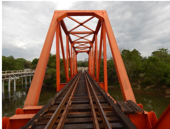
Figura 52. Trabajos de modificación en portales y tornapuntas
