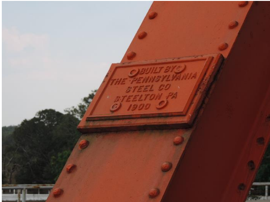
Figura 2. Placa de construcción de la estructura
