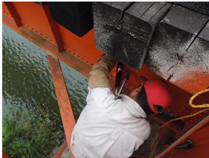
Figura 27. Extracción de muestras para probetas de acero.
