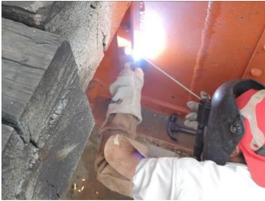
Toma de muestra de placa de acero en atiesador
