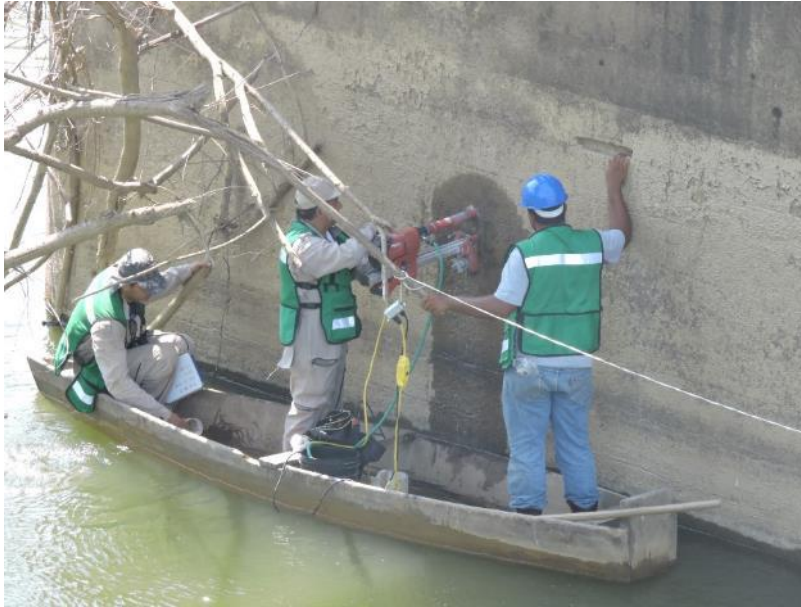
Figura 23. Extracción de núcleos de concreto en pila No. 3
