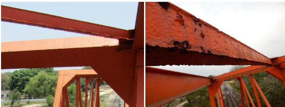
Figura 17. (a) Tornapunta extremo y (b) tornapunta intermedio)
