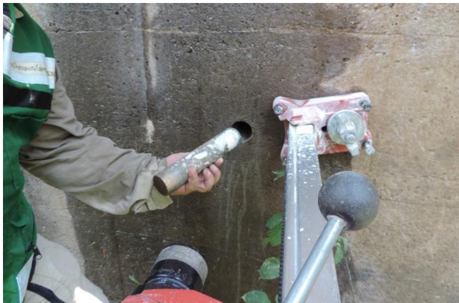
Figura 24. Núcleo de concreto extraído
