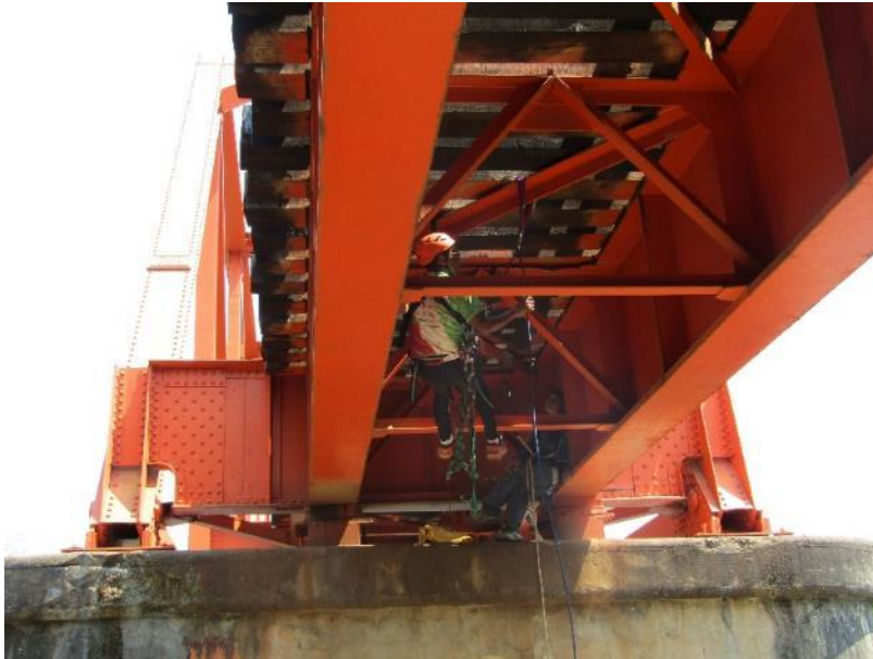
Figura 10. Inspección y levantamiento geométrico
