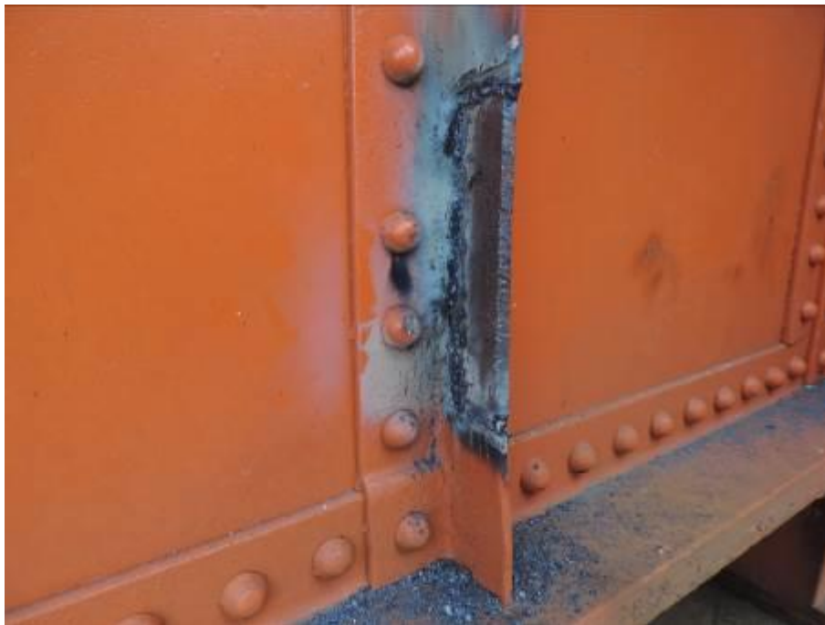
Restitución de muestras de placas de acero
