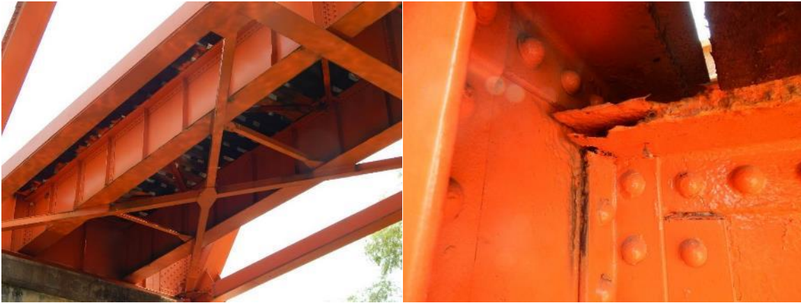
Figura 22. (a) Vista general de los largueros y (b) Detalle de conexión de larguero con pieza puente
