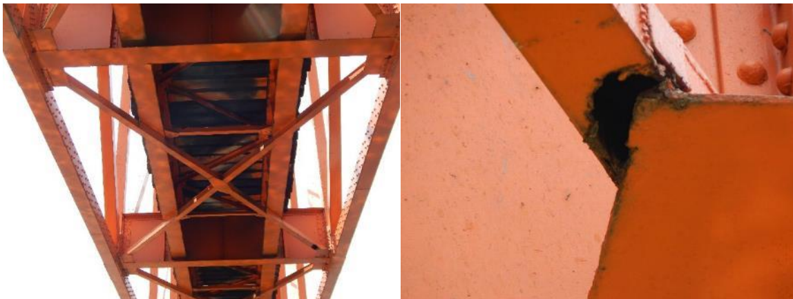
Figura 19. (a) Vista general del contraventeo inferior y (b) detalle de conexión de contraventeo con pieza puente
