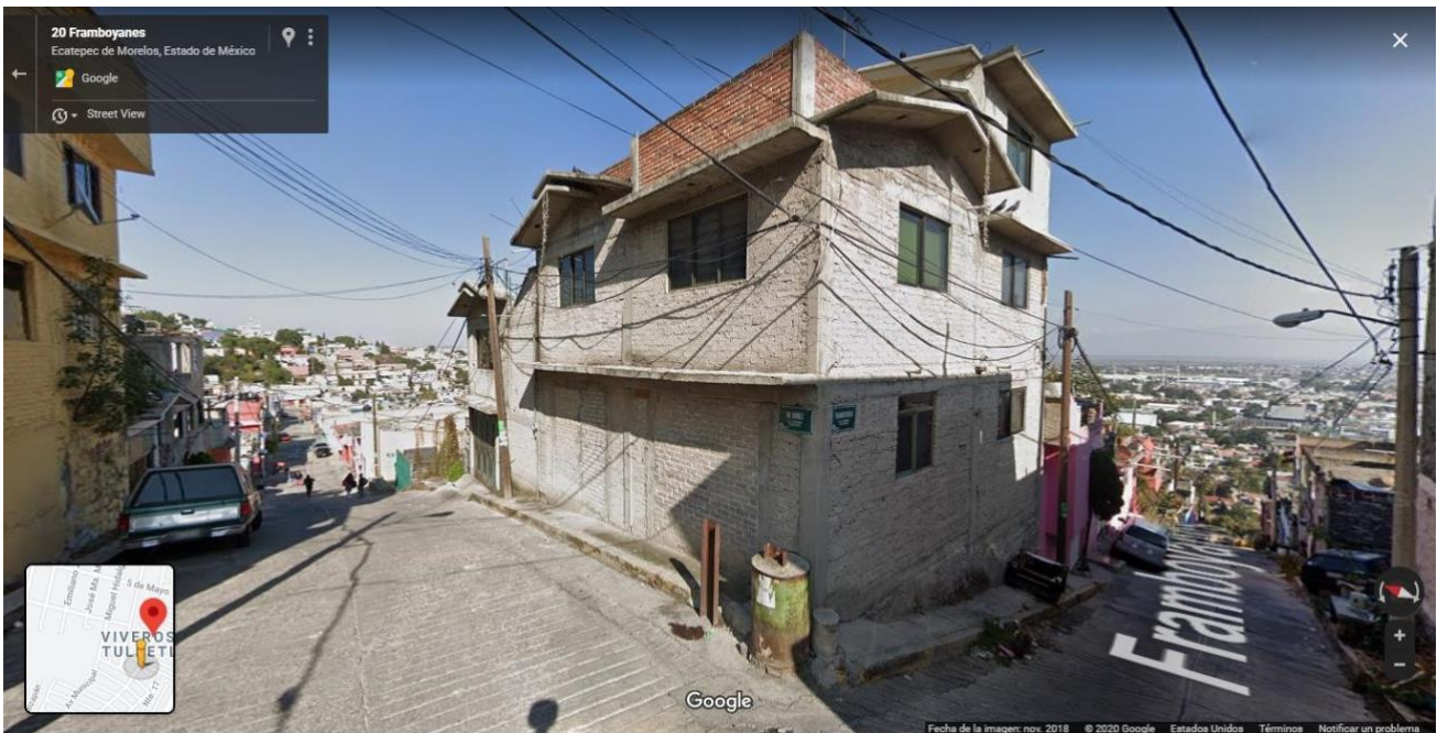
Figura 3. 13 Construcciones de varios pisos en las calles empinadas de la colonia
