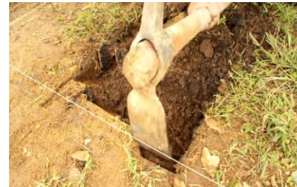
Figura 103. Excavación. Nota. (MEDES y ASF. 2013, 6m51s)
