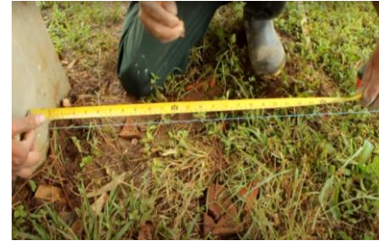
Figura 102. Nivelación de cimentación. Nota. (MEDES y ASF. 2013, 6m42s)
