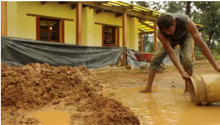
Figura 93. Hidratación de materiales. Nota. (MEDES y ASF. 2013, 4m24s)
