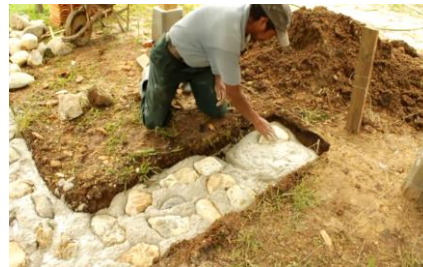
Figura 105. Rellenar zanja. Nota. (MEDES y ASF. 2013, 7m41s)
