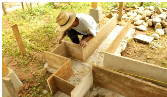
Figura 106. Trazo de sobrecimentación. Nota. (MEDES y ASF. 2013, 7m53s)
