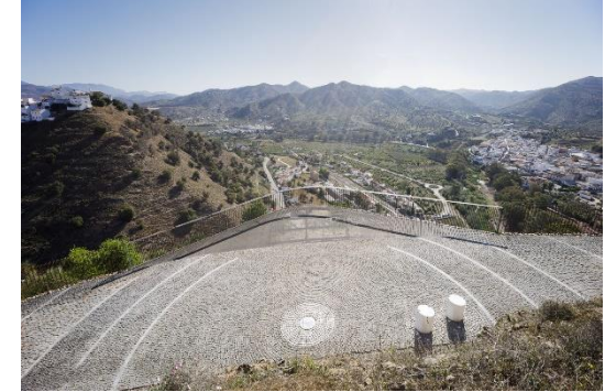
Figura 67. Vista del contexto
