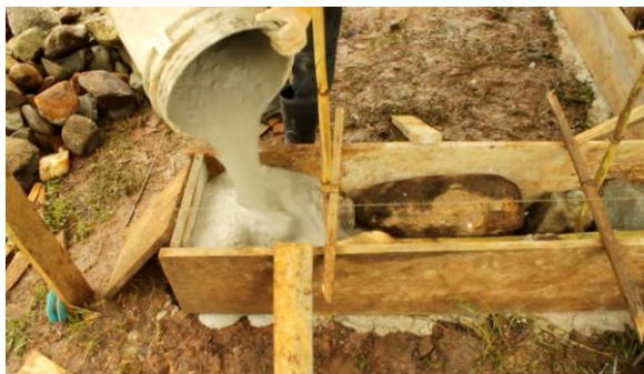
Figura 107. Verter mezcla. Nota. (MEDES y ASF. 2013, 9m26s)
