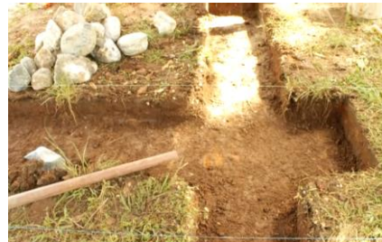
Figura 104. Limpieza de cimentación. Nota. (MEDES y ASF. 2013, 7m05s)
