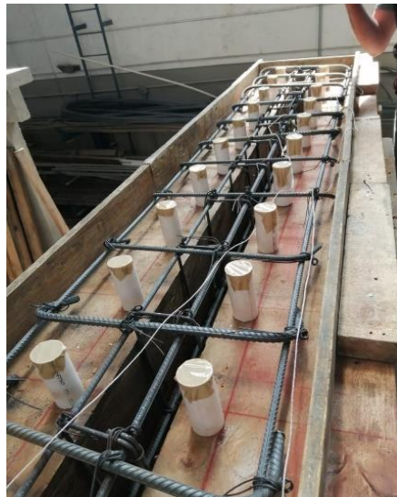
a. Cimbrado de confinamiento superior.
