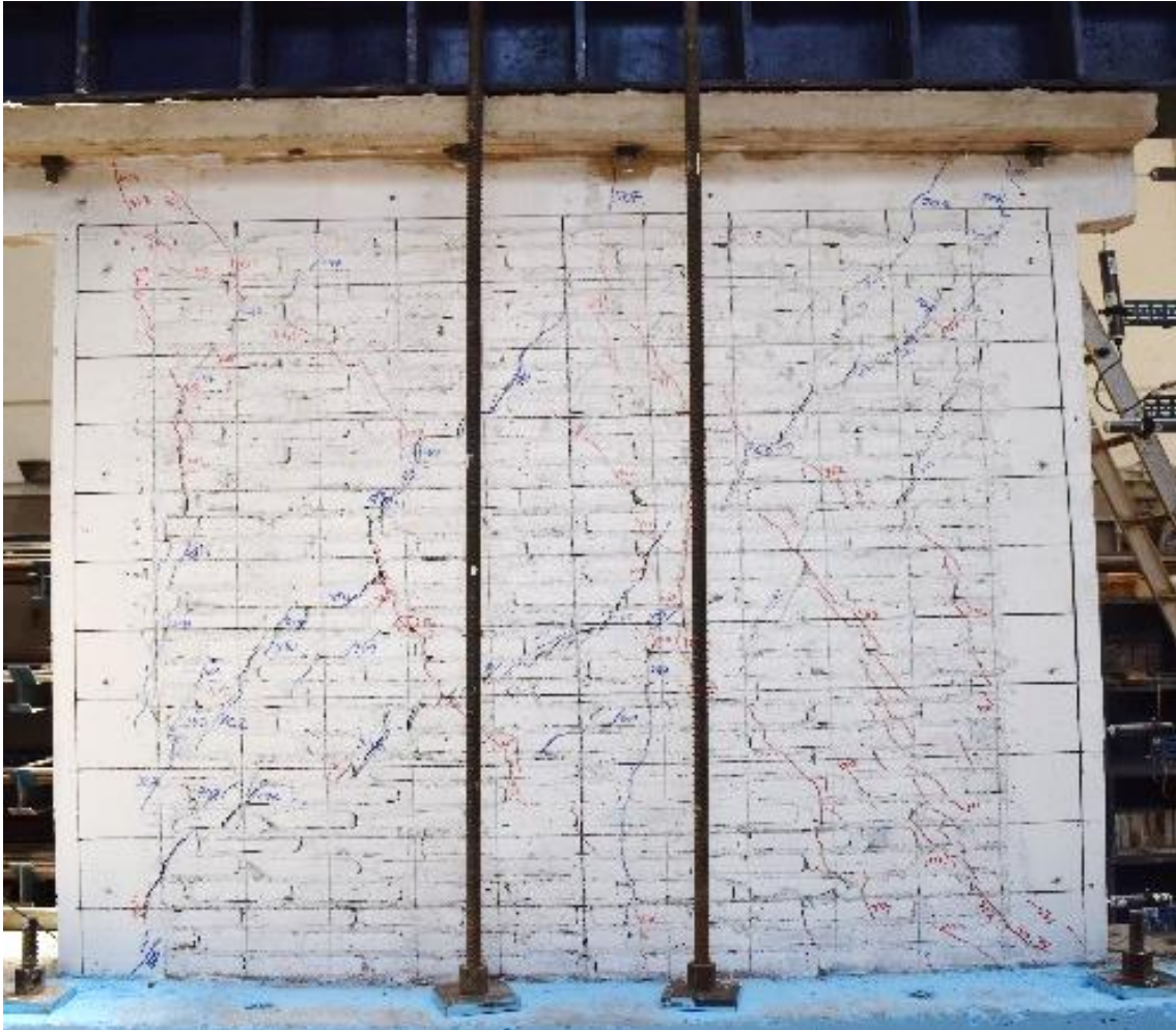
Figura 4.22. Estado final del muro 3.
