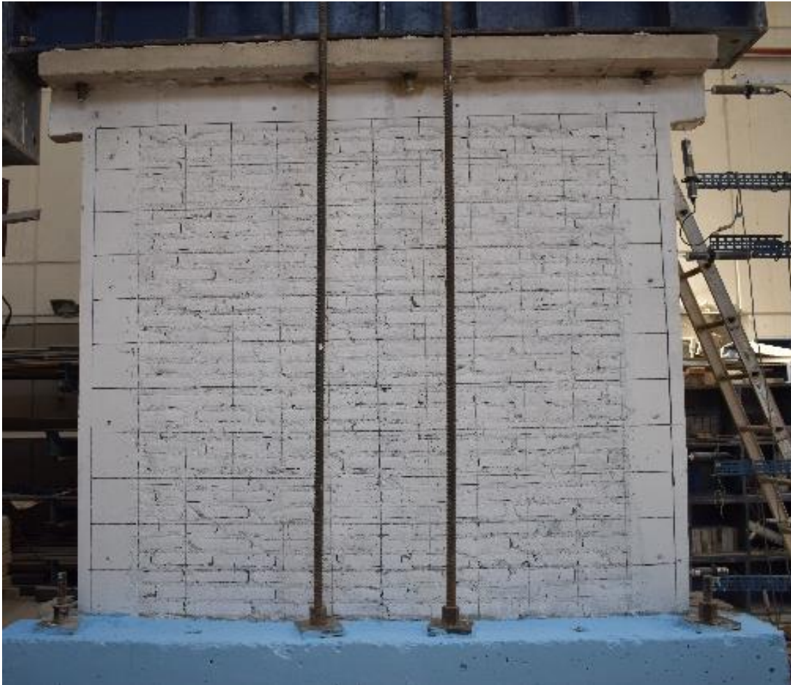
Figura 4.20. Muro 3 al final de la etapa controlada por carga.
