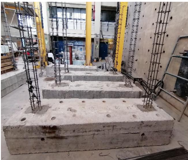
b. Primera etapa de colado (castillos –cimentación).
