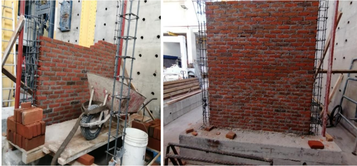
a. Colocación de hiladas de las piezas.
