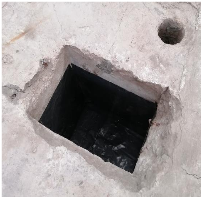
a. Recubrimiento con plástico al interior de los huecos.
