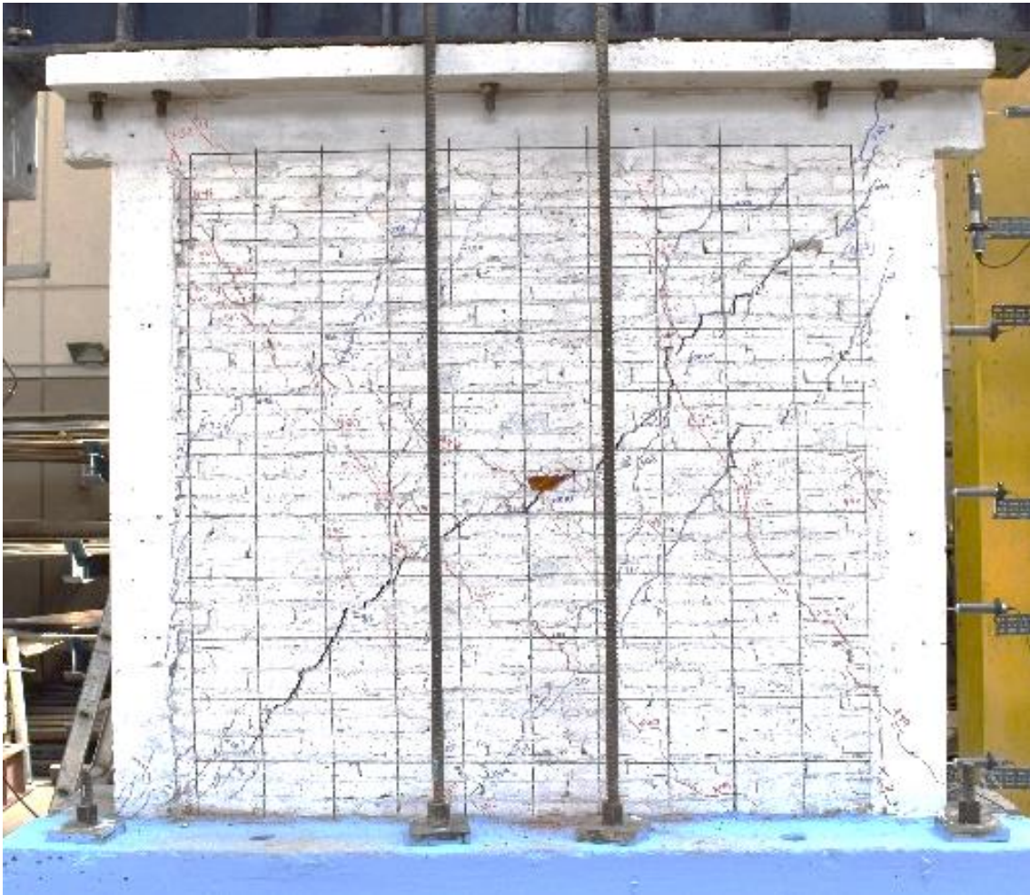
Figura 4.31. Estado final del muro 4.
