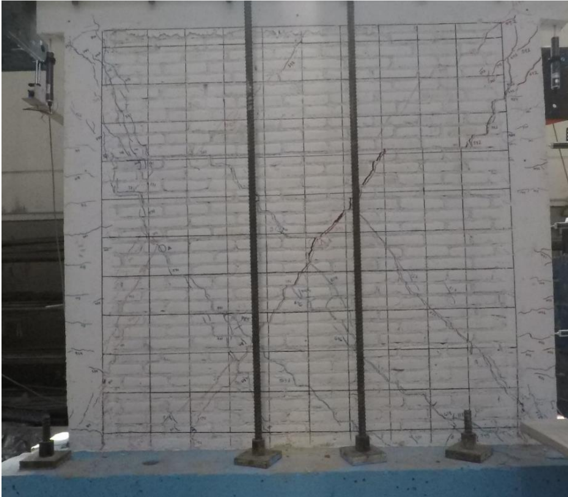
Figura 4.12. Daños en el muro 2 a una distorsión de 0.0015.
