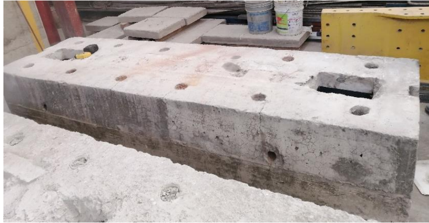
Figura 3.12. Limpieza y disposición de la viga de cimentación.
