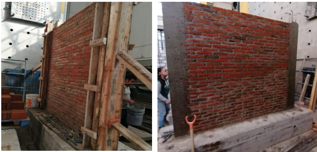
a. Colocación cimbra para castillos.
