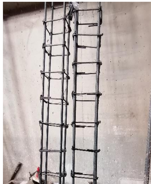
b. Armado de castillos sencillos.
