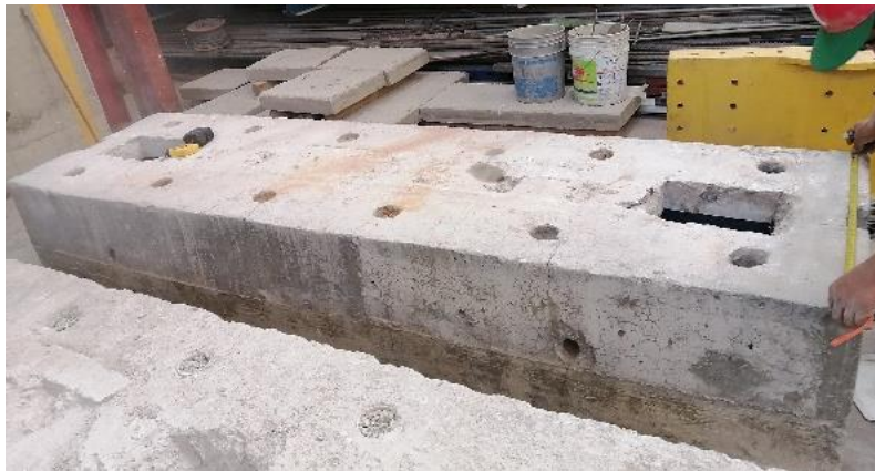
Figura 3.6. Viga de cimentación.
