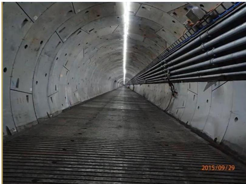
Figura 6.7 Mina Grosvenor 15% pendiente. Piso prefabricado (Ibid.)
