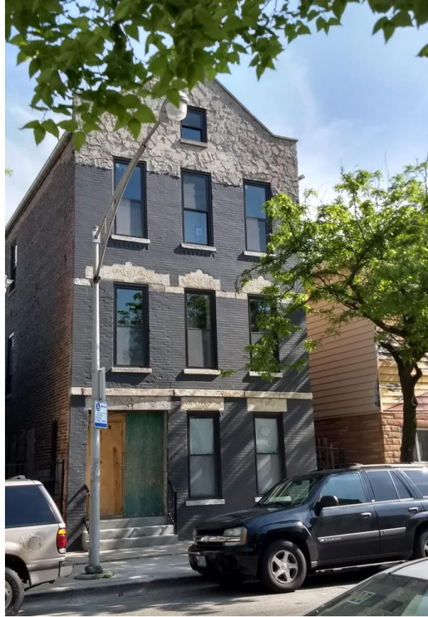
Fotografía 11. Casa en reconstrucción sobre Cullerton St. Fuente: Archivo personal, mayo de 2018.
