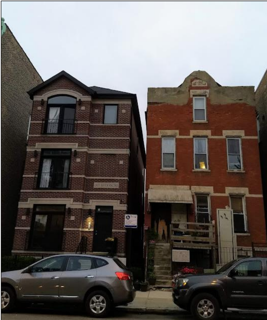
Contrastes de la gentrificación. Edificios renovados y edificios carentes de mantenimiento.
