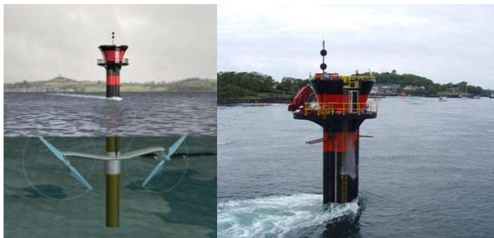
**Figura 2.4.** Rotores y estructura del proyecto SeaGen en Irlanda, [2.7].
