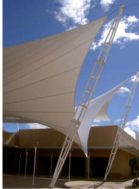
Postes de alma abierta. Cubierta para patio de centro comercial en Tulancingo, Hidalgo, México. https://www.tensinet.com
