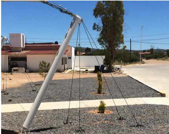
Cables de retenida. Cubierta para cancha deportiva en Durango, México. https://www.lymarquitecturatextil.com
