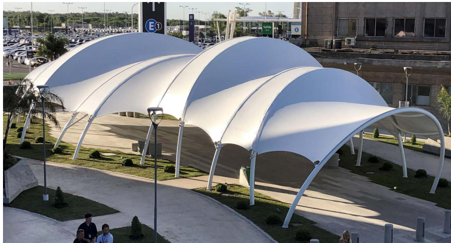
Postes rolados o arcos de alma abierta. Cubierta en aeropuerto de Ezeiza, Buenos Aires, Argentina. https://wagg.com.ar/obras
