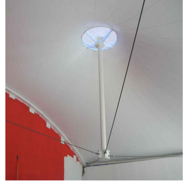
Poste flotante. Cubierta para restaurante en León, Guanajuato, México. https://tenso.mx
