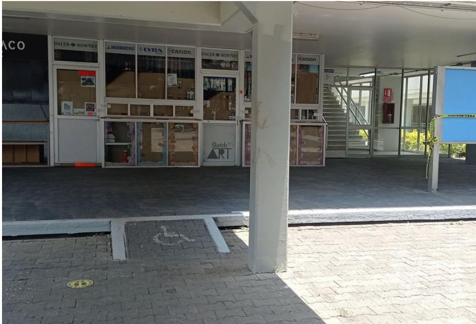
Figura. 4- Ubicación del nuevo consultorio médico en el edificio 2 planta baja.
