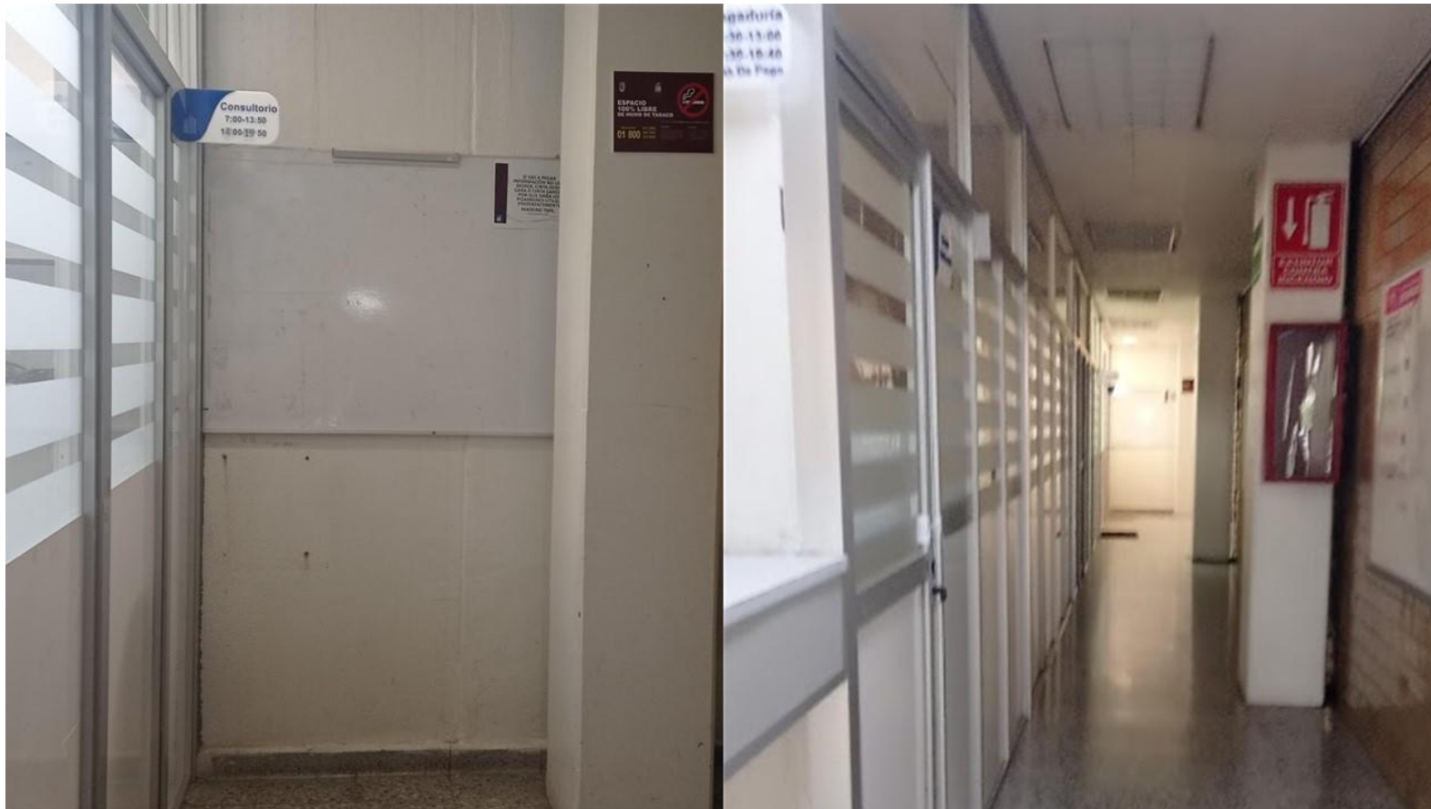
Figura. 4- Ubicación del antiguo consultorio médico de la ESIA Tecamachalco, Edificio de Gobierno planta baja.
