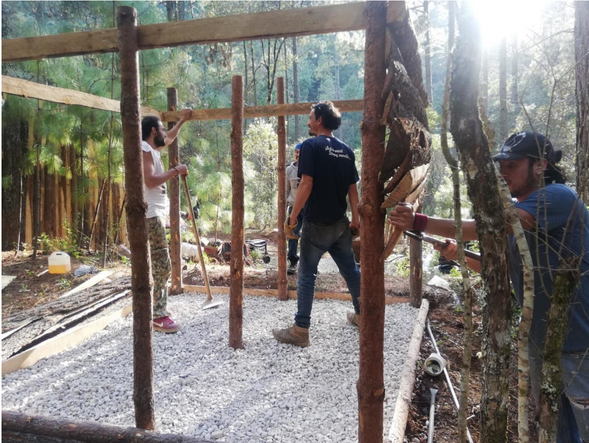
Fotografía 6: Alonso, Arcturus, Nehuen y Carlos comenzando la construcción de las regaderas del campamento general.
