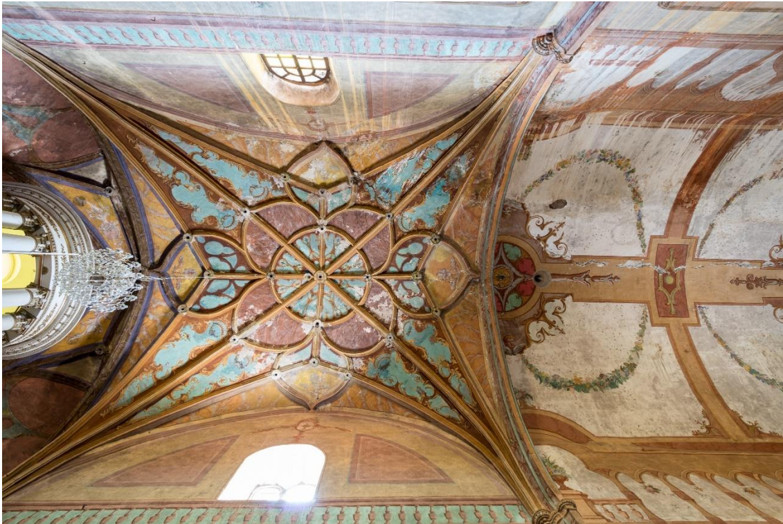
Imagen 74. Bóveda de crucería en el presbiterio. Fotografía: Ricardo Alvarado Tapia, Archivo Fotográfico Manuel Toussaint del IIE, UNAM, 2017.
