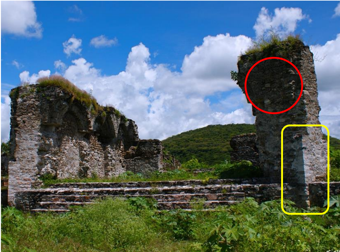
Imagen 35. Acercamiento a los muros de la primera iglesia dominica en Olintepec. En el cuadrado amarillo se marcan las caras externas construidas con roca cortada de forma rectangular. Mientras que en el círculo rojo se muestra el muro de relleno y el acomodo correspondiente de las rocas. Fotografía tomada de https://mexicolindoyquerido.com.mx/mexico2/images/IMAGENES_PARA_TEMPLATE/zona_s_arqueologicas_de_mexico/P19_zona_arqueologica_olintepec_morelos.png
