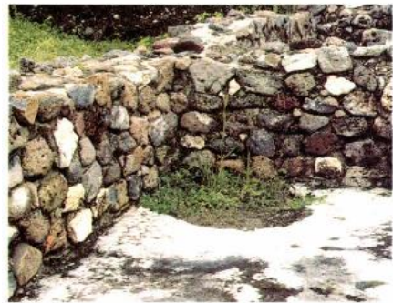
Detalle de construcción
