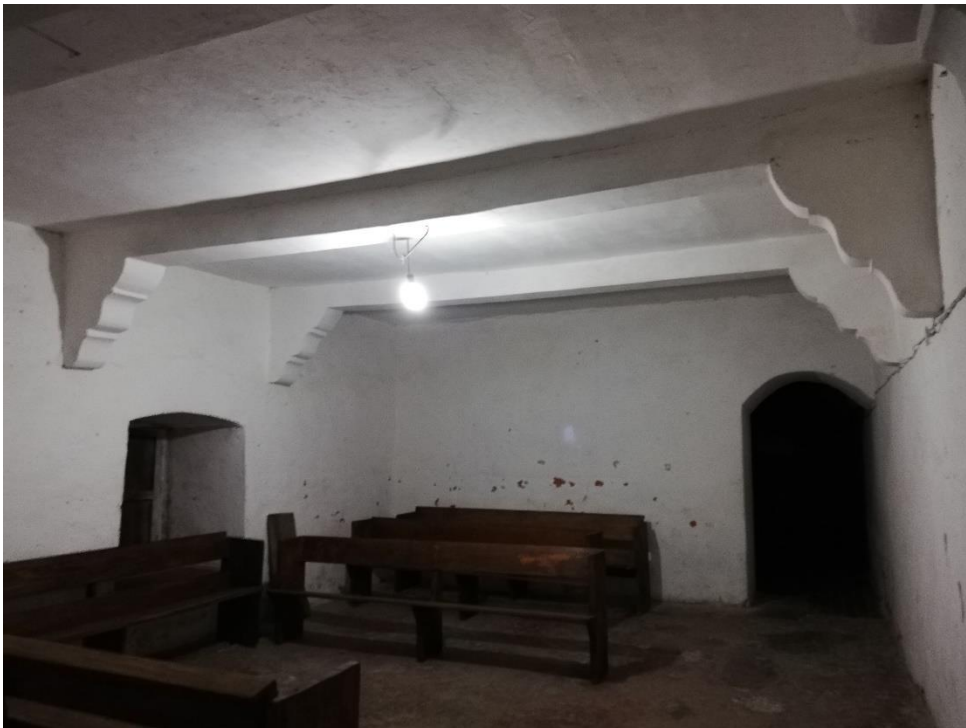
Imagen 122. Trabes de concreto colocadas para sostener el techo de los sótanos del lado oeste del convento. Fotografía: Leticia Domínguez, 2019.
