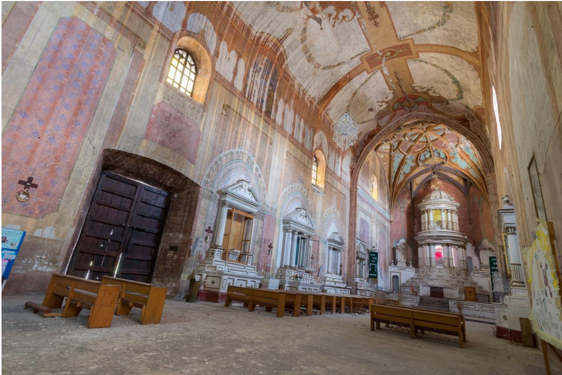
Imagen 4. Interior del templo, bóveda de cañón corrido y bóveda de crucería en el presbiterio. Fotografía: Ricardo Alvarado, Archivo Fotográfico Manuel Toussaint del IIE, UNAM, 2017.
