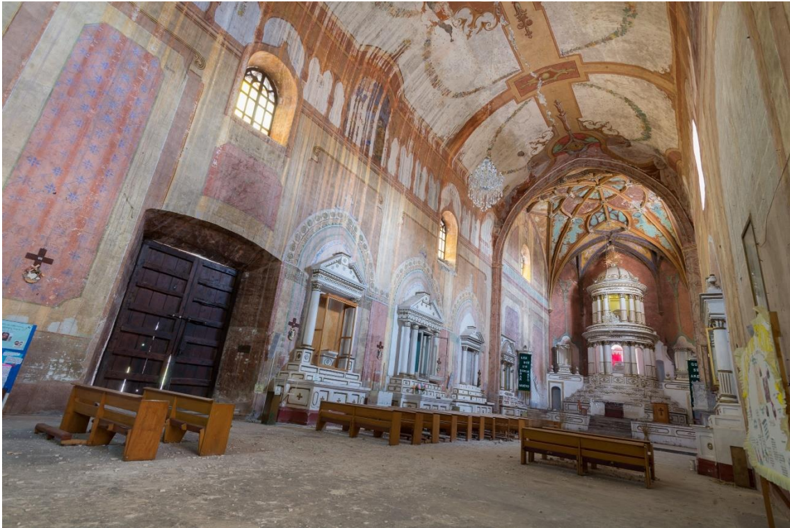
Imagen 45. Interior del templo, bóveda de cañón corrido y bóveda de crucería en el presbiterio. Fotografía: Ricardo Alvarado, Archivo Fotográfico Manuel Toussaint del IIE, UNAM, 2017.
