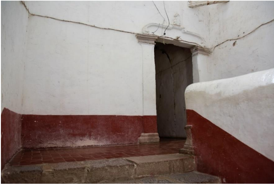
Imagen 127. Primer descanso de las escaleras desde donde se accede al área de celdas por un vano decorado con pilastras de cantera gris. En el siglo XIX se agregaron los roleos en yesería. Fotografía: Eumelia Hernández, Laboratorio de Diagnóstico de Obras de Arte, Instituto de Investigaciones Estéticas, UNAM, 2019.
