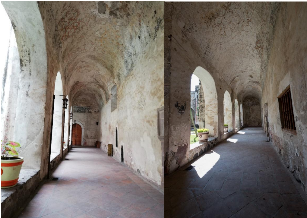
Imagen 102. Corredor lado sur. En él no quedan restos de vano cerrados o áreas tapiadas. Fotografía: Óscar Hernández, 2019.
