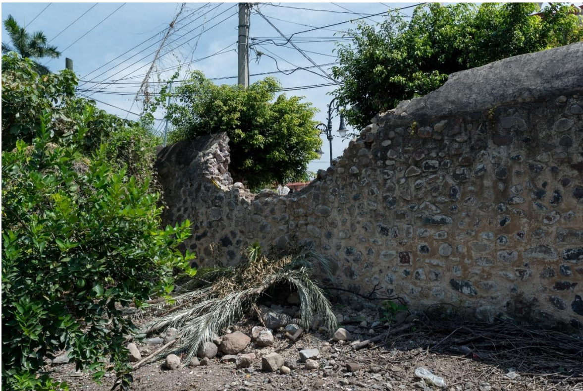
Imagen 54. Barda del lado sur de la huerta que se derrumbó a causa del sismo del 2017. Fotografía: Ricardo Alvarado, Archivo Fotográfico Manuel Toussaint del IIE, UNAM, 2017.
