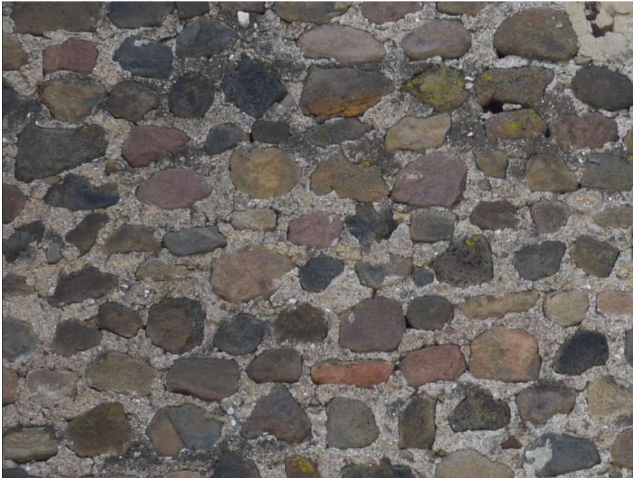
Imagen 49. Detalle de las diferentes rocas que se emplearon para la construcción del muro norte de la iglesia. Fotografía: Óscar Hernández, 2019.
