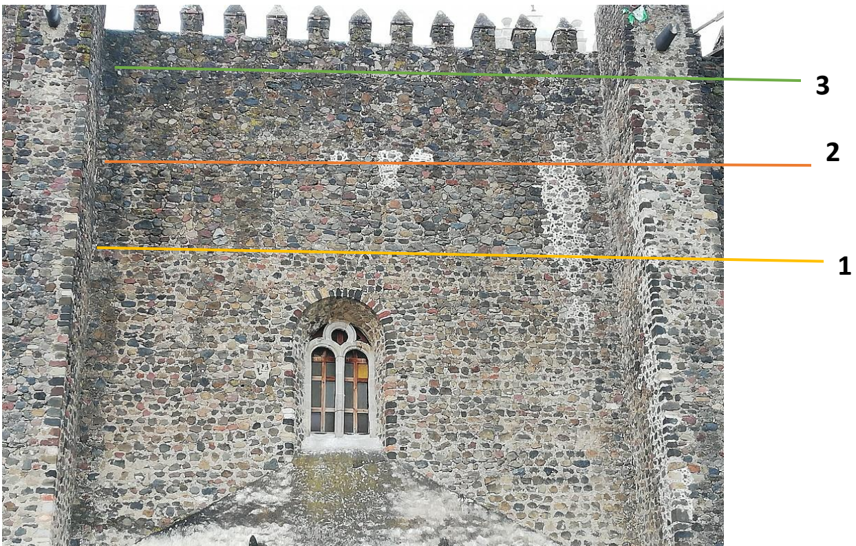
Imagen 48. Los tres tipos de mamposterías en el muro norte. Fotografía: Leticia Domínguez, 2019.
