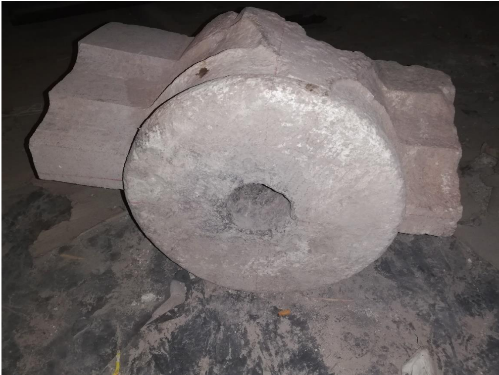
Imagen 59. Piedra clave de la bóveda de crucería del ábside que se cayó en el sismo del 19 de septiembre del 2017. Fotografía: Leticia Domínguez, 2020.
