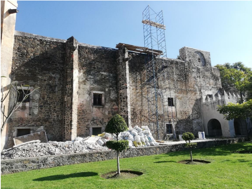
Imagen 118. Construcción destinada a las habitaciones seculares. Fotografía: Leticia Domínguez, 2020.
