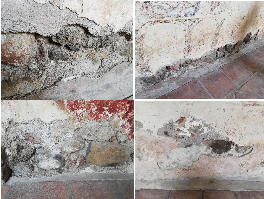
Imágenes 96-99. Tipos de rocas utilizados en la construcción de los muros de mampostería del claustro. Fotografías: Leticia Domínguez, 2019.
