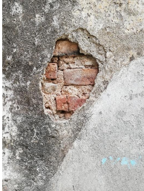
Imágenes 105-106. Contrafuertes del lado sur y detalle del material constructivo de uno de los contrafuertes del claustro. Fotografías: Leticia Domínguez, 2019.
