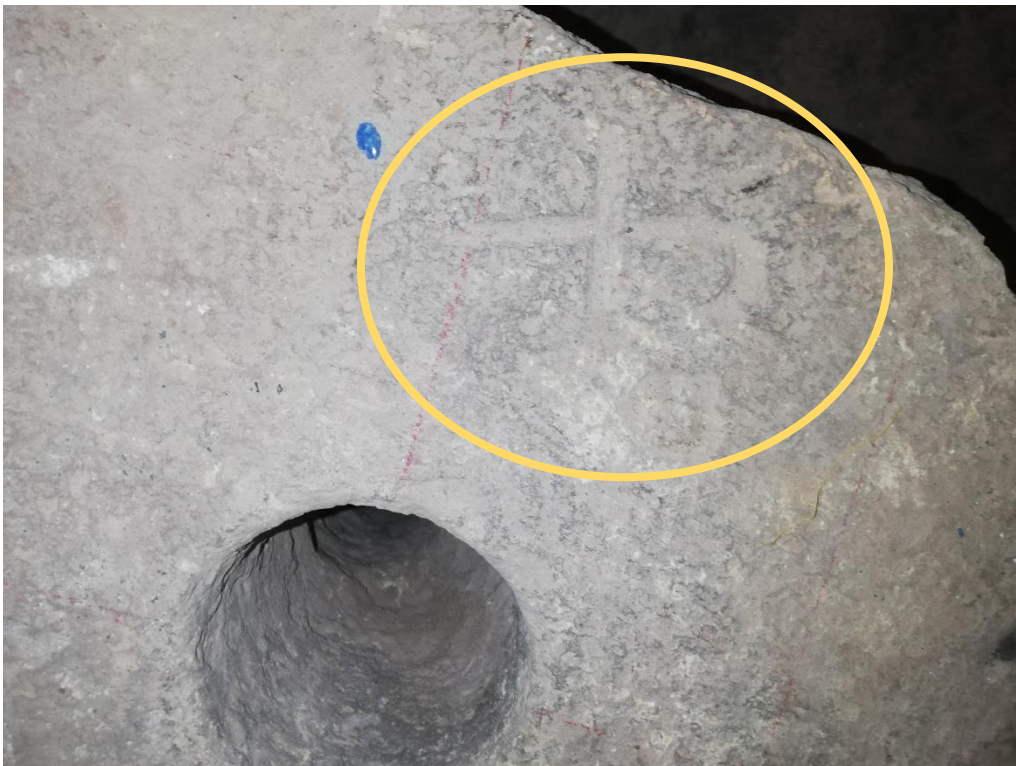
Imagen 60. Detalle de la marca de cantero en forma de “fº” localizada en la piedra clave del crucero de la bóveda del ábside. Fotografía: Leticia Domínguez, 2020.
