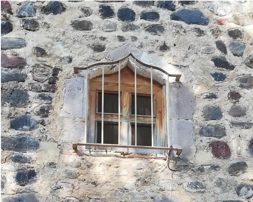
Imagen 72. Ventana de una celda donde se distingue la reutilización de piezas de cantera para formar un arco ojival. Fotografía: Leticia Domínguez, 2020.
