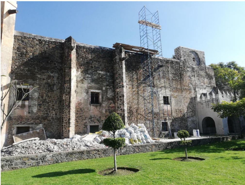
Imagen 9. Área de celdas lado oeste. Fotografía: Leticia Domínguez, 2020.
