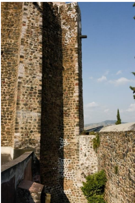
Imagen 52. Mampostería del ábside y los contrafuertes. Aunque tenga diferentes restauraciones con cemento, se logra observar la homogeneidad del mamposteo y del mortero. Fotografía: Eumelia Hernández, Laboratorio de Diagnóstico de Obras de Arte, Instituto de Investigaciones Estéticas, UNAM, 2019.
