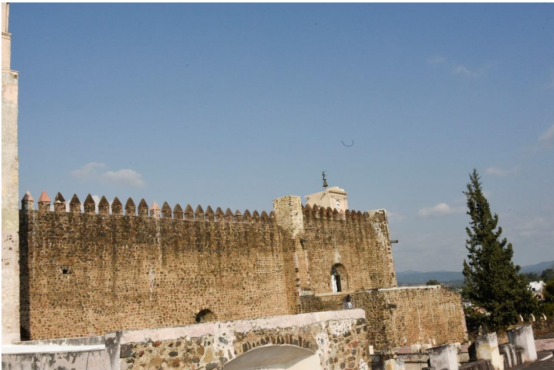
Imagen 50. Muro sur del templo. Fotografía: Eumelia Hernández, Laboratorio de Diagnóstico de Obras de Arte, Instituto de Investigaciones Estéticas, UNAM, 2019.
