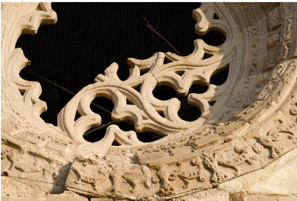
Imagen 56. Detalle de la tracería del rosetón de la portada principal del templo de Yecapixtla. Fotografía: Eumelia Hernández, Laboratorio de Diagnóstico de Obras de Arte, Instituto de Investigaciones Estéticas, UNAM, 2019.
