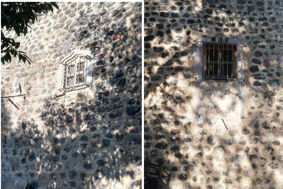
Imágenes 116-117. Detalles de las ventanas de las celdas con vistas a la huerta. Una de ellas tiene un marco de cantera reutilizado en forma de ojiva y todas tenían un diseño más alargado, pero se tapiaron posteriormente. Fotografías: Leticia Domínguez, 2019.
