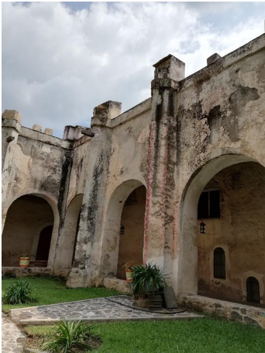
Imágenes 105-106. Contrafuertes del lado sur y detalle del material constructivo de uno de los contrafuertes del claustro. Fotografías: Leticia Domínguez, 2019.
