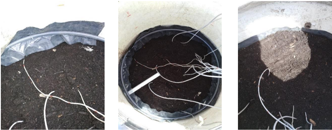
Figura 3.6 Muestra de un deflector instalado al interior del biofiltro
