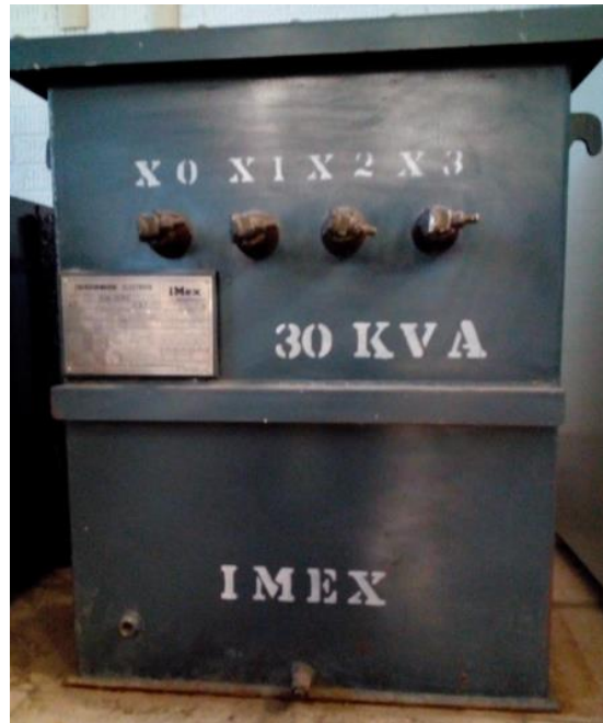
1.1 Transformador trifásico, terminales de baja tensión, conexión estrella.
