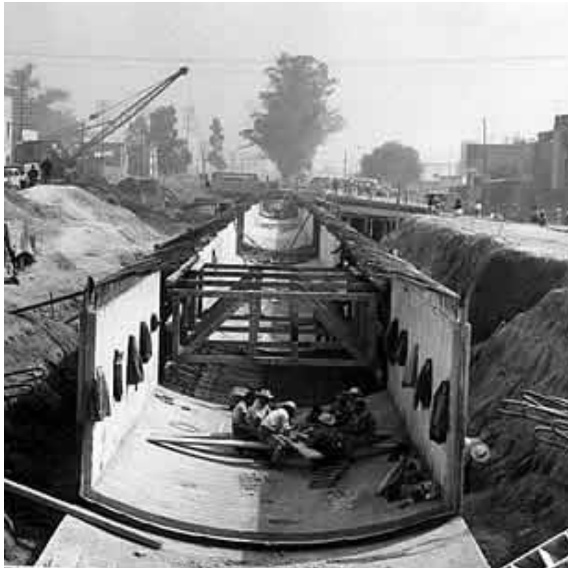
Ciudad de México Antigua. 1. La preparación para entubar el río la ciudad. 3. Construcción para entubar el río Churubusco.
