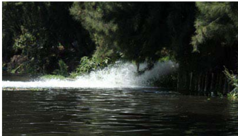
Salida de Planta de Tratamiento Cerro de la Estrella sobre canal Apatlaco
