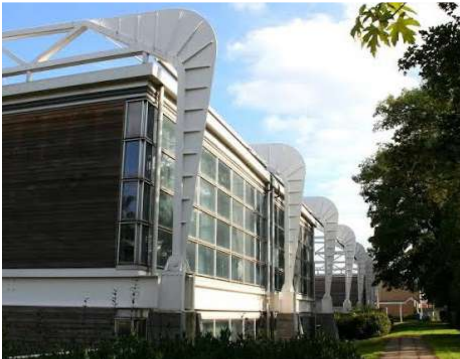
Imagen 14.5 Estructura de Escuela del Brit
