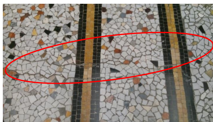
GRIETAS S y T, respectivamente. Ubicadas al centro del Salón, la grieta S , presenta aberturas de 2 a 4.5 mm, con profundidades de grieta de 0 a 3.1 mm, mientras que la grieta T , tiene aberturas que van de 1 a 3.3 mm y profundidades de grieta de 0 a 2 mm.
