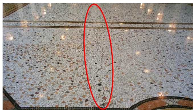
GRIETAS Q y R, respectivamente. Ubicadas casi al centro del Salón, la grieta Q , presenta aberturas de 2.8 a 3 mm y con levantamiento de mosaico de 2 mm, mientras que la grieta R , tiene aberturas que van de 1.6 a 5 mm y profundidades de 0 a 3.1 mm.
