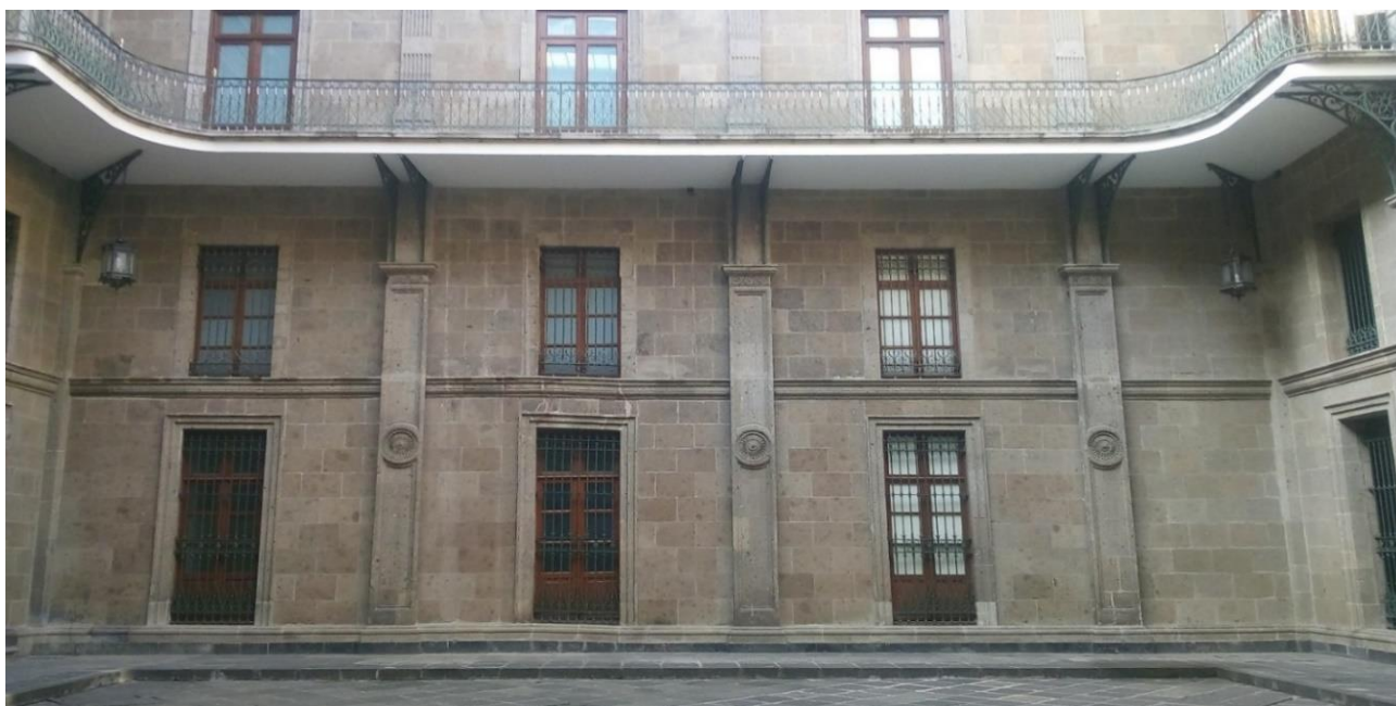
Continuación de la Fachada Norte de la Ex Tesorería Guillermo Prieto (3 er . Patio Mariano).
