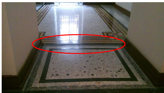
GRIETA X'. La grieta se encuentra ubicada en la junta de unión del mosaico, presenta una abertura de 8 mm, con una profundidad de 2.1 cm y 1 cm de levantamiento en el piso, no hay pérdida de material.
