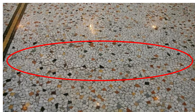
GRIETAS S y T, respectivamente. Ubicadas al centro del Salón, la grieta S , presenta aberturas de 2 a 4.5 mm, con profundidades de grieta de 0 a 3.1 mm, mientras que la grieta T , tiene aberturas que van de 1 a 3.3 mm y profundidades de grieta de 0 a 2 mm.
