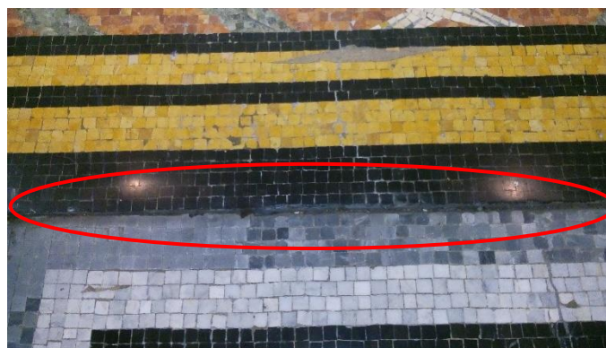
GRIETA X'. La grieta se encuentra ubicada en la junta de unión del mosaico, presenta una abertura de 8 mm, con una profundidad de 2.1 cm y 1 cm de levantamiento en el piso, no hay pérdida de material.
