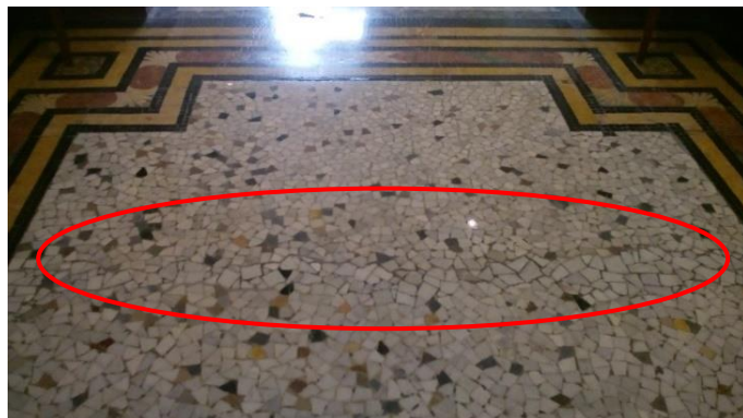
GRIETAS Q'1, Q'2 y Q'3. Estos segmentos están ubicados en el centro del mosaico, tienen de 1mm a 2.5 mm de abertura, no tienen profundidad y tampoco existe pérdida de material.
