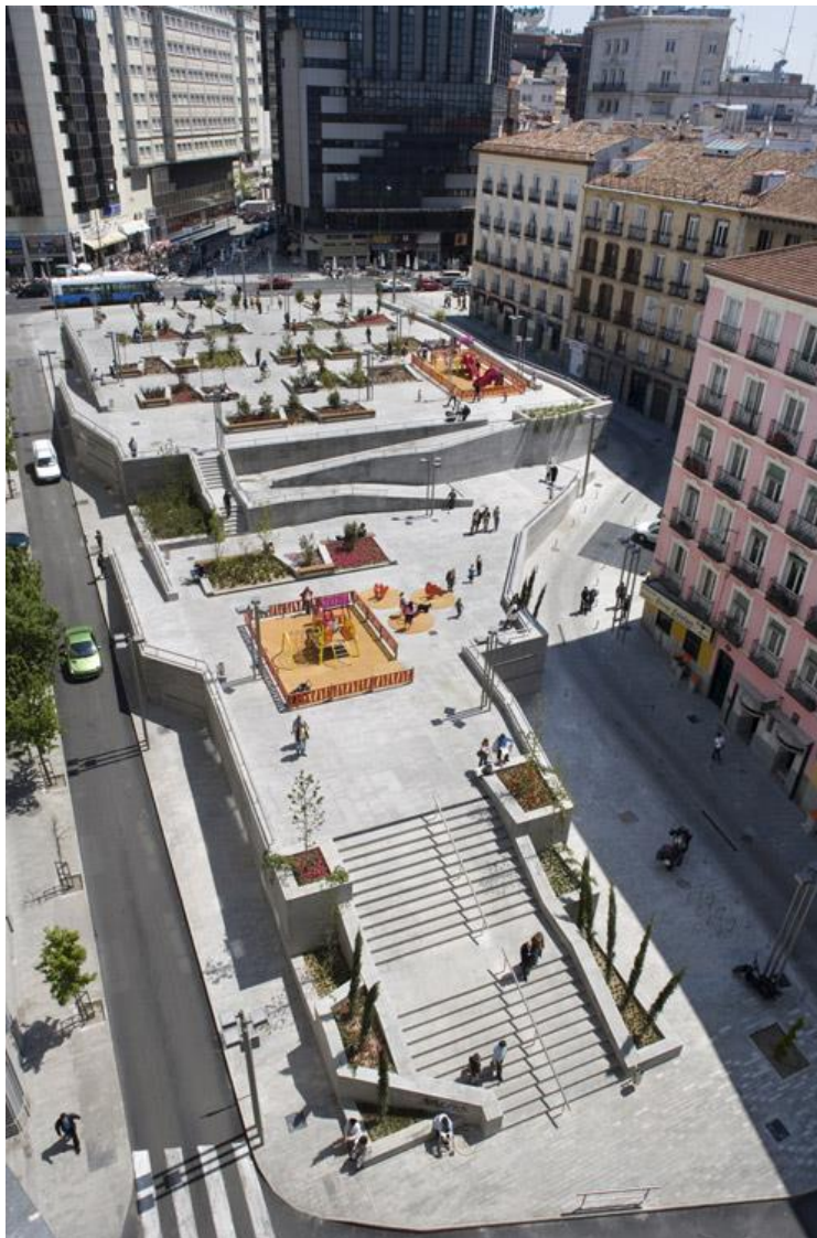
Figura 1.9 Vista aérea del proyecto Recuperación de la plaza Santo Domingo 17 .
