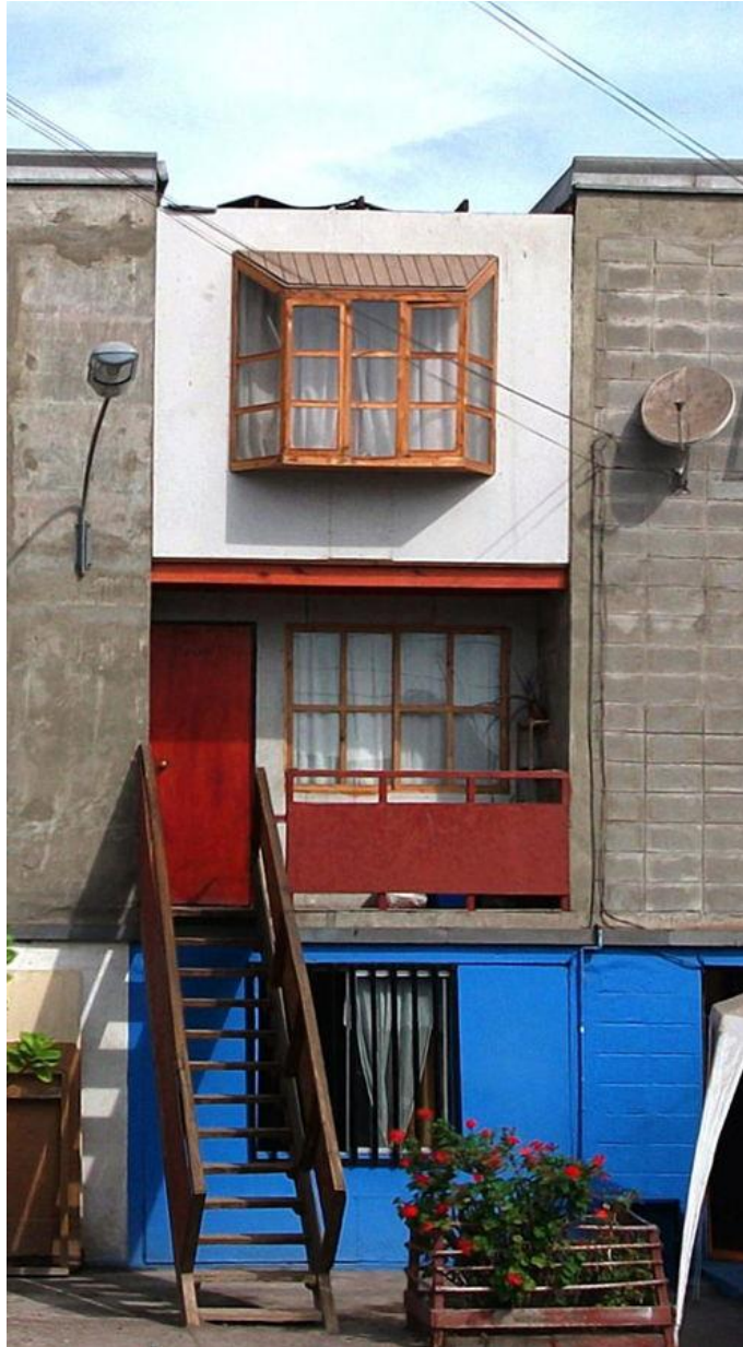
Figura 13. Modificaciones de prototipo de vivienda. Villa verde Housing, Constitución Chile. Fotografía original de Infinity Lab , 2018.
